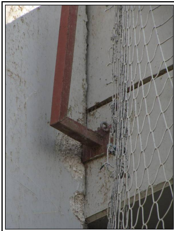
Desconchones en aleta izquierda de hastial dos
