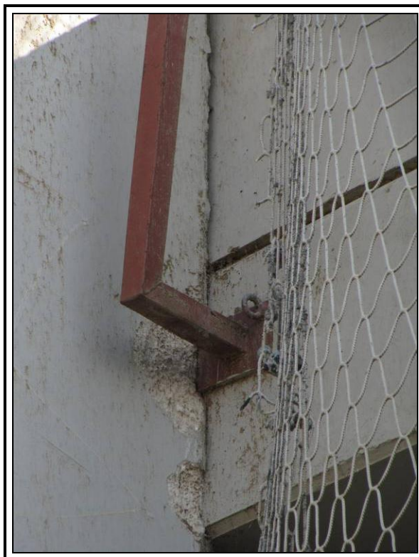
Desconchones en aleta izquierda de hastial dos
