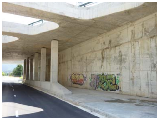
Fotografía nº 7. Estribo de entrada
