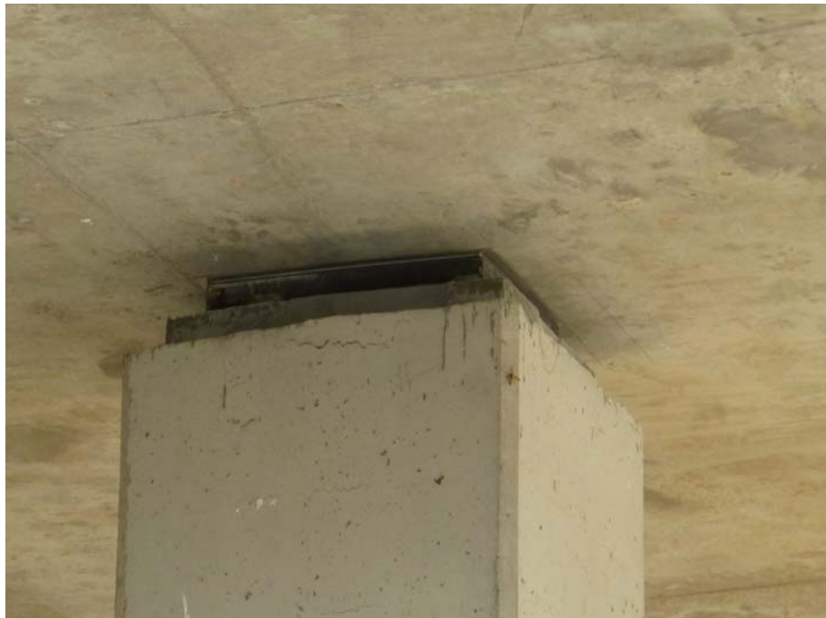
FOTOGRAFIA N° 38: Detalle de uno de los aparatos de apoyo en pilas
