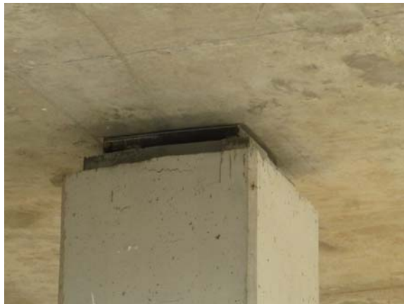
Fotografía nº 9: Detalle de aparato de apoyo
