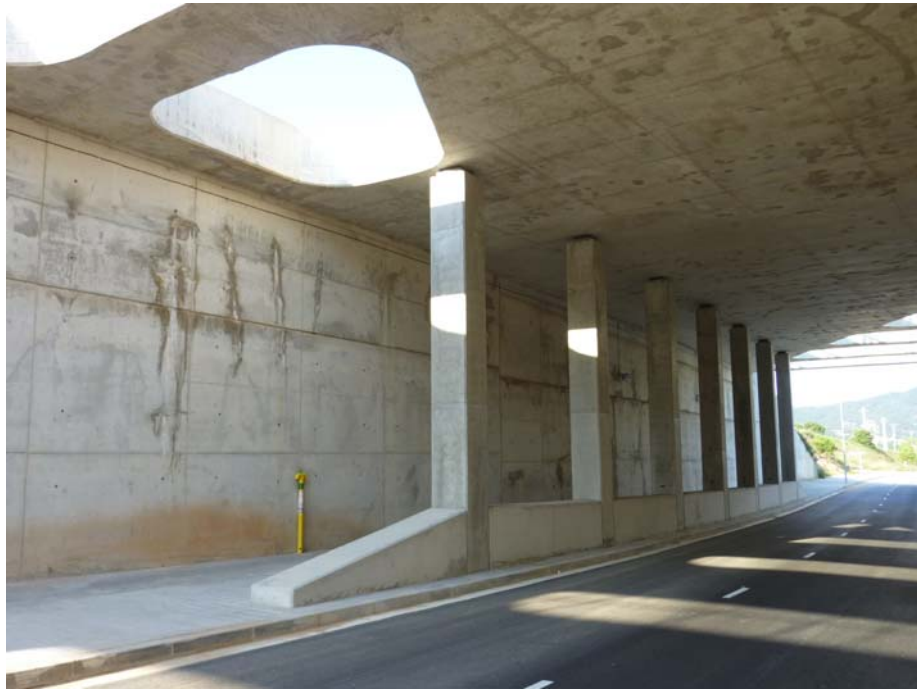
FOTOGRAFIA N° 37: Alineación de pilas n° 2
