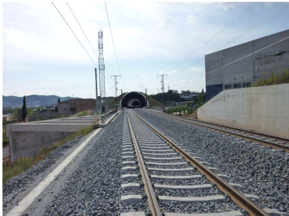
FOTOGRAFIA Nº 2: Vista superior del tablero dirección Barcelona
