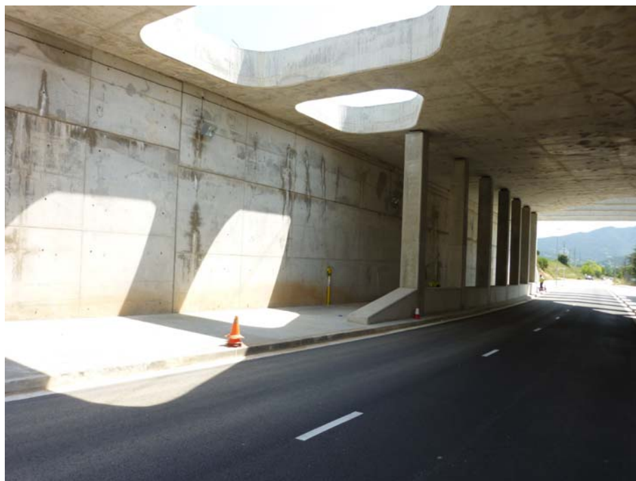
FOTOGRAFIA N° 11: Vista del hastial de salida
