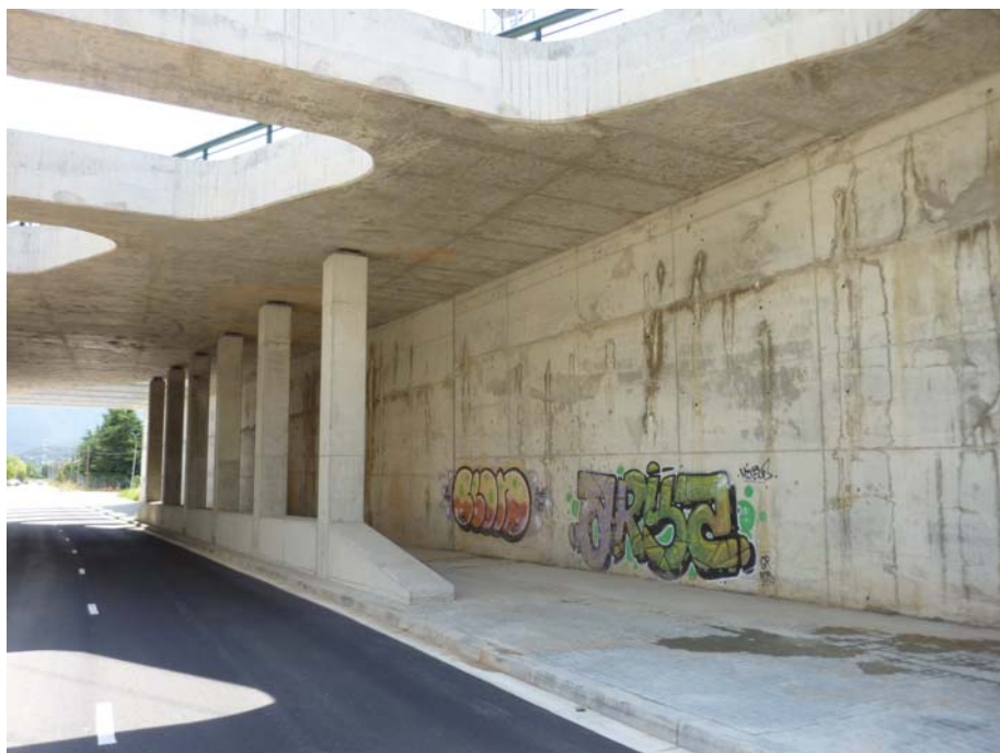
FOTOGRAFIA N° 10: Vista del hastial de entrada
