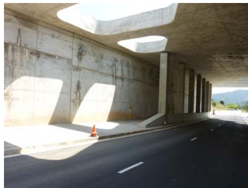
Fotografía nº 8. Estribo de salida
