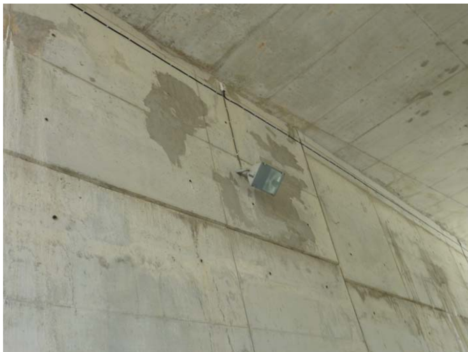
FOTOGRAFIA N° 25: Reparaciones en el hastial de salida
