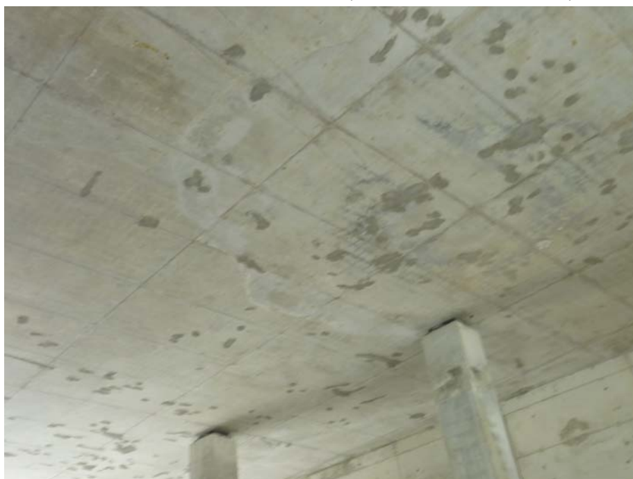
FOTOGRAFIA N° 34: Reparaciones en el paramento inferior de la losa superior
