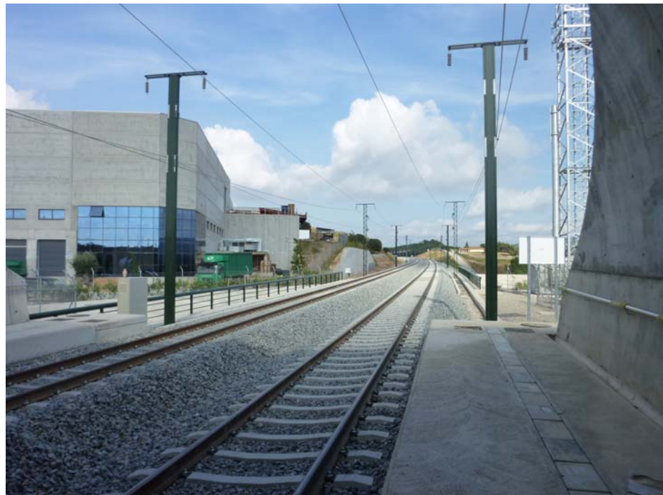
FOTOGRAFIA Nº 1: Vista Superior del tablero dirección Figueres
