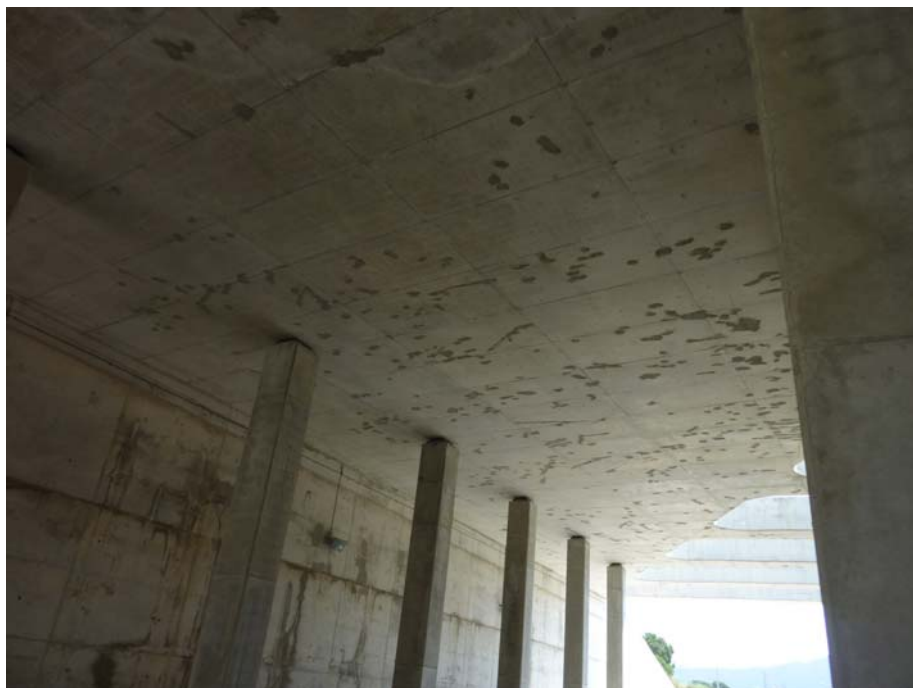
FOTOGRAFIA N° 35: Reparaciones en el paramento inferior de la losa superior
