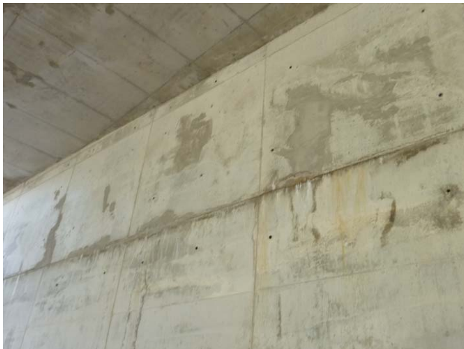
FOTOGRAFIA N° 20: Reparaciones en el hastial de entrada
