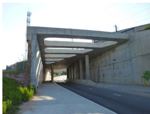
Fotografía nº 2. Estructura tras el refuerzo
