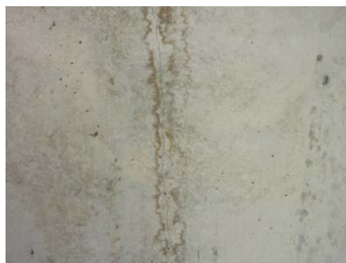
Fotografía nº 13. Fisura en el hastial de salida
