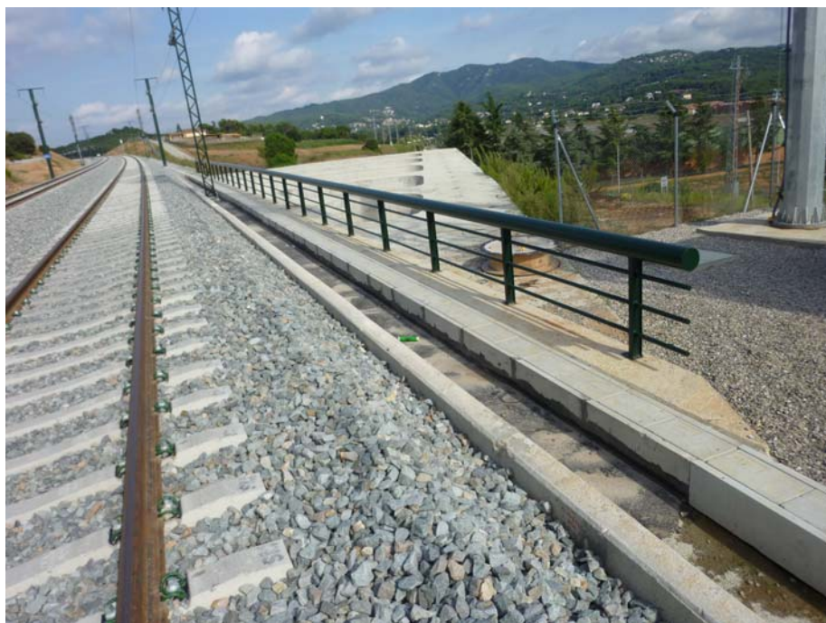
FOTOGRAFIA N° 8: Vista del lado derecho de la plataforma
