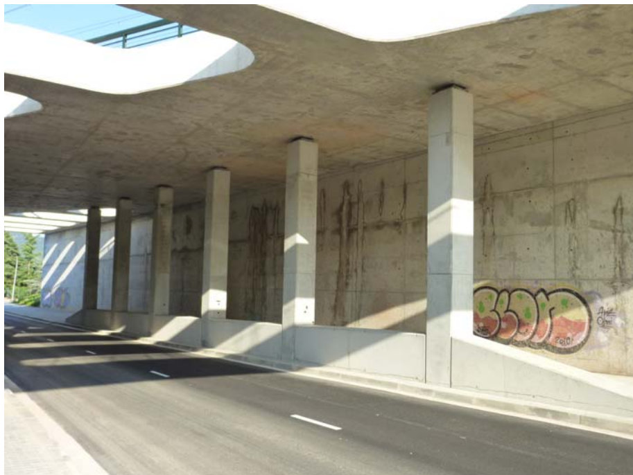
FOTOGRAFIA N° 36: Alineación de pilas n° 1
