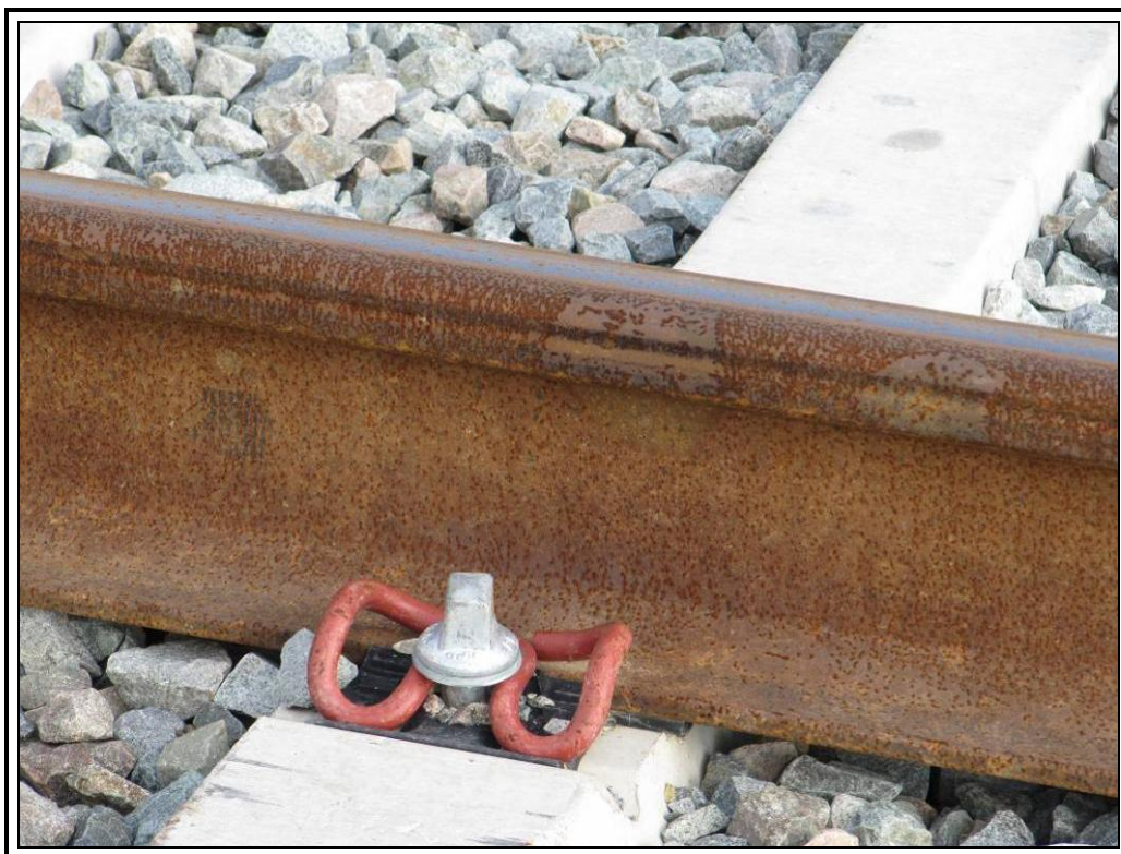
Material de vía.
