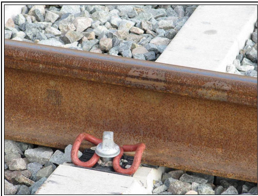
Material de vía.
