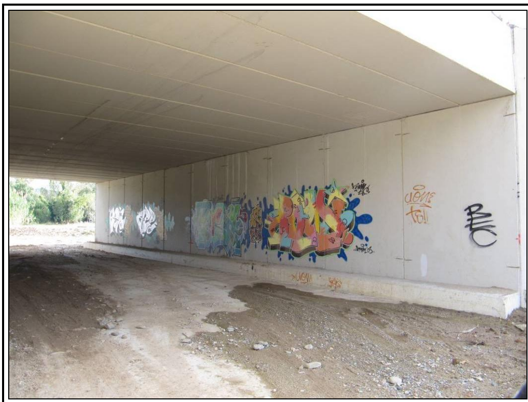
Estribo de entrada
