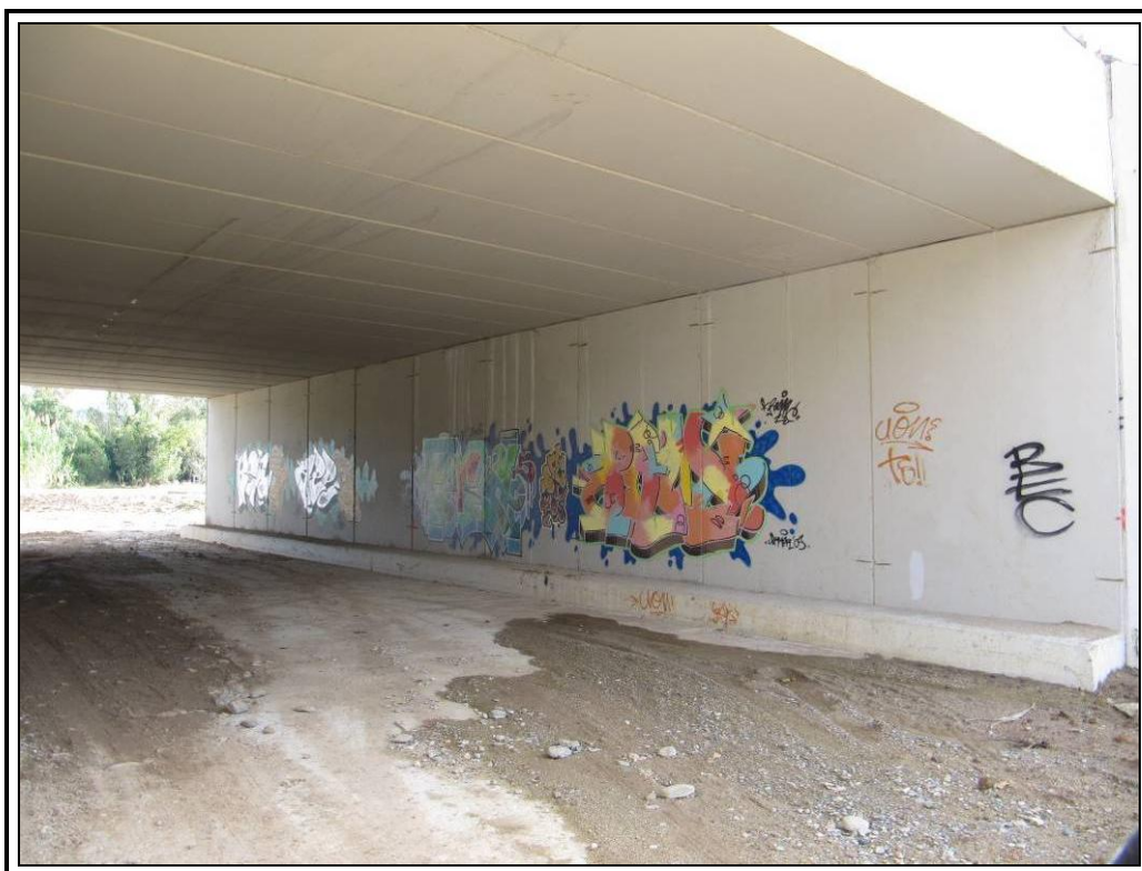
Estribo de entrada
