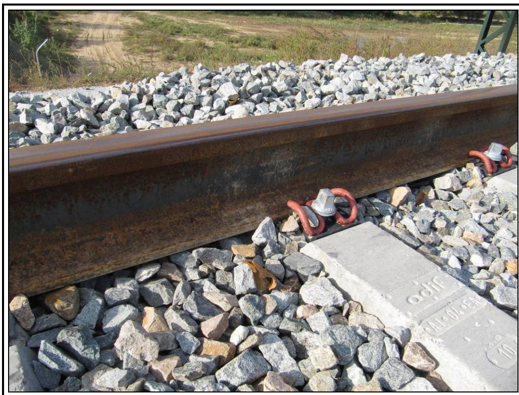
Material de vía.
