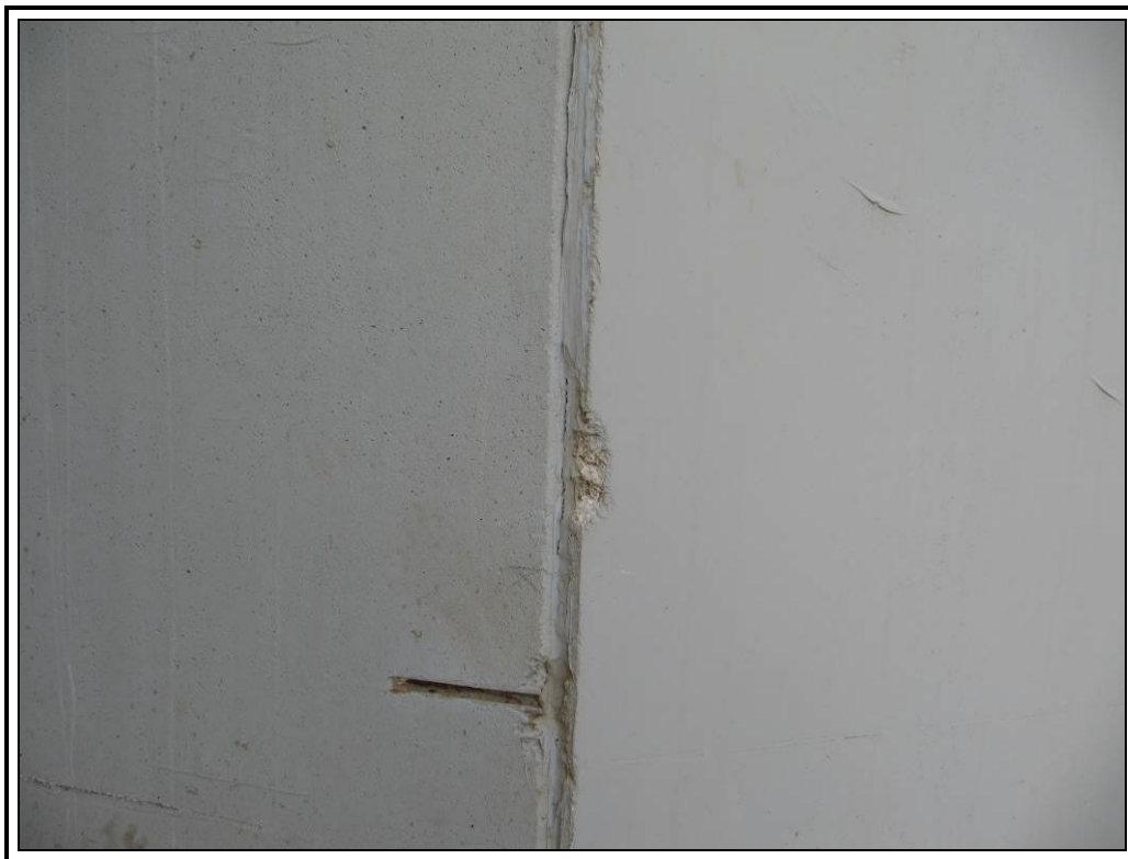
Leve desconchón en aleta derecha de hastial dos.
