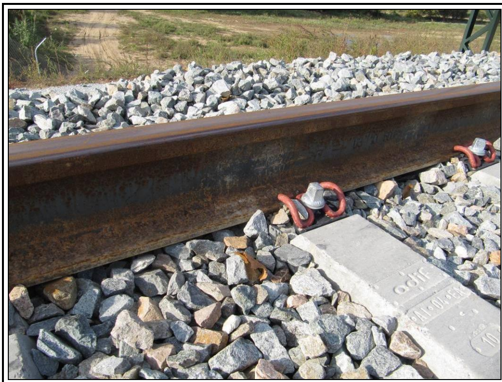
Material de vía.
