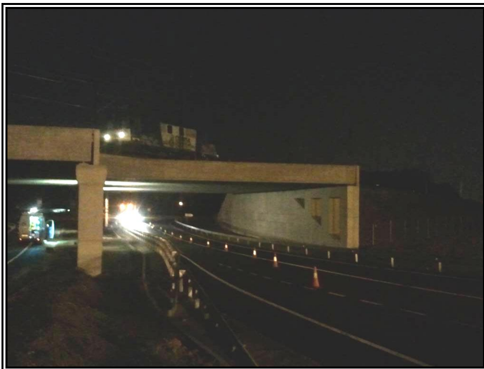
Nº 9.- Prueba estática Estado Nº 1 (Pérgola Nº 1).
