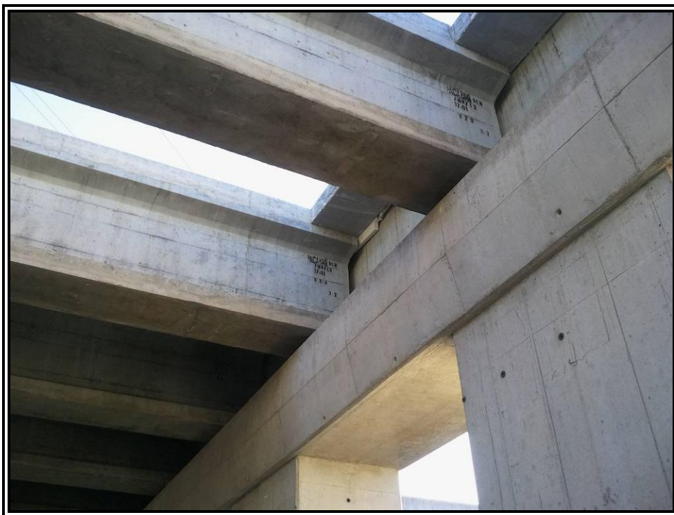
Nº 5.- Detalle de las vigas.
