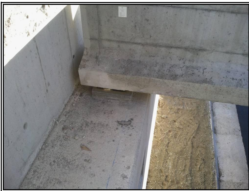
Nº 6.- Apoyo de una de las vigas.
