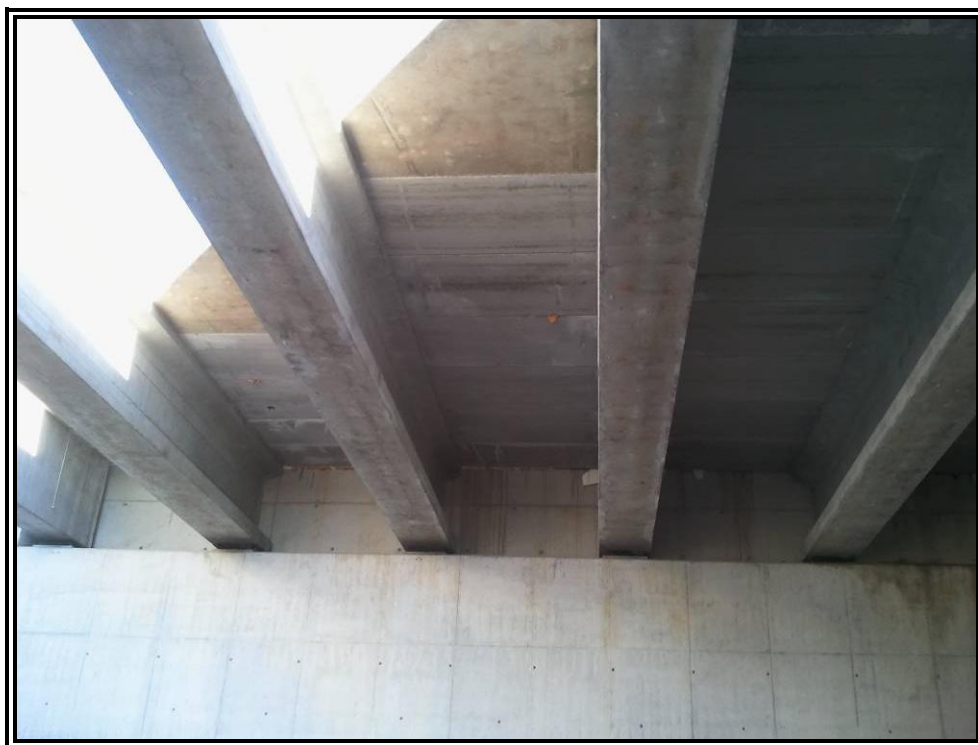
Nº 4.- Vista inferior de la estructura.
