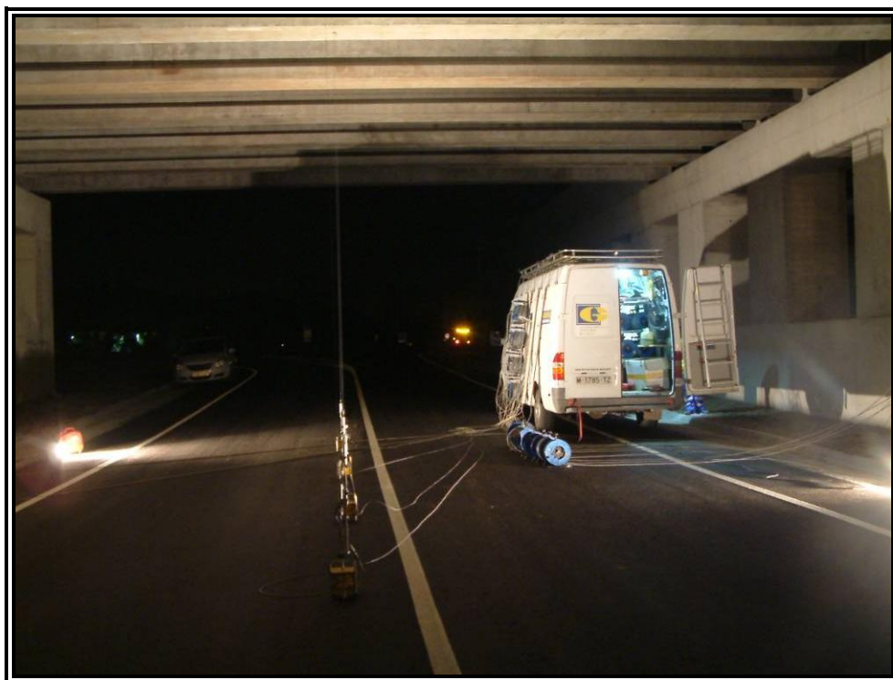
Nº 8.- LVDT's instalados en centro de vano.
