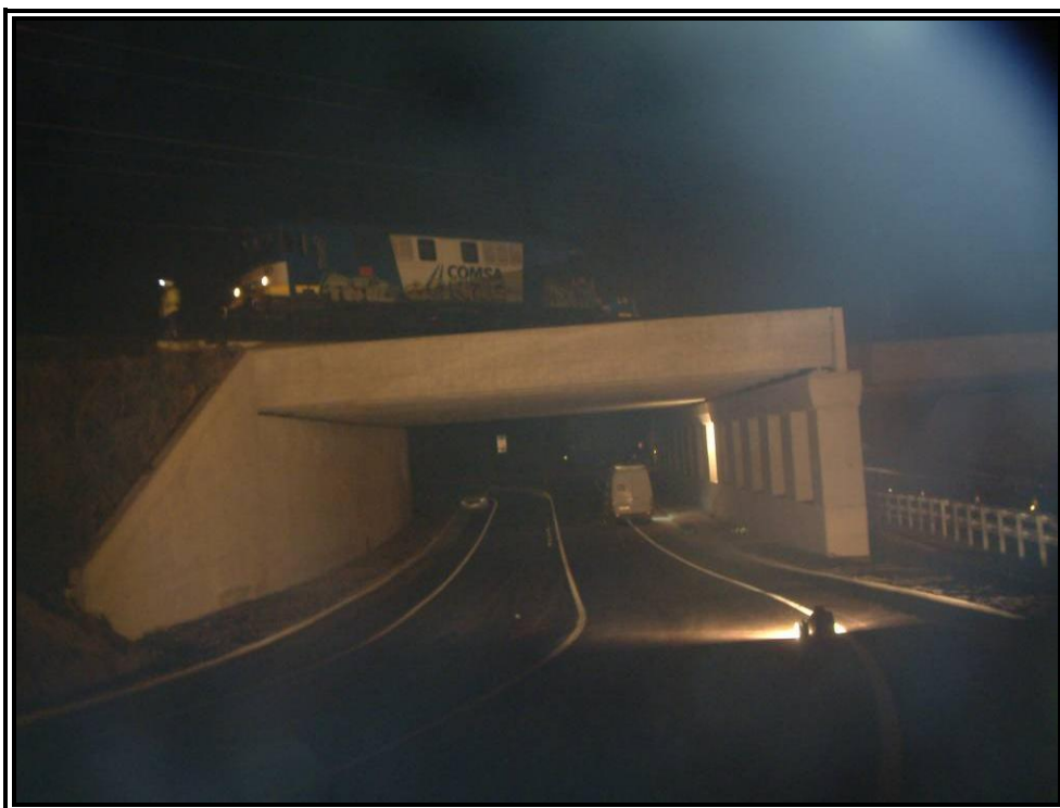
Nº 10.- Prueba estática Estado Nº 2 (Pérgola Nº 2).
