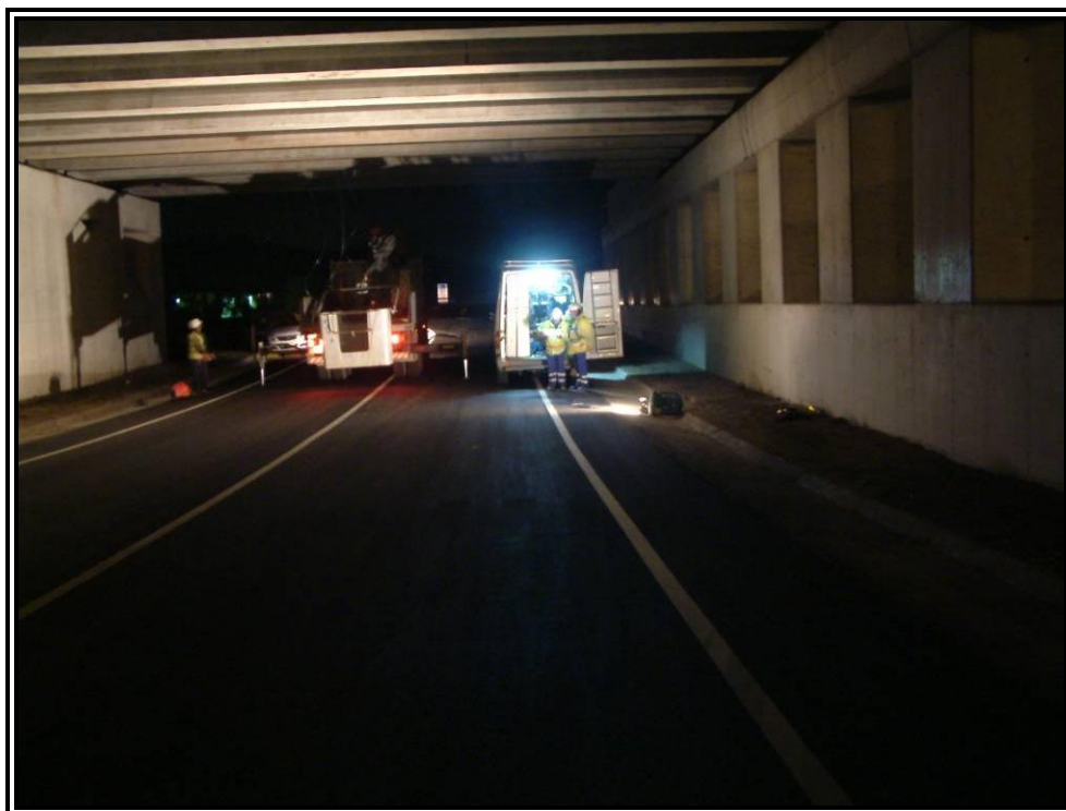
Nº 7.- Instalación de instrumentación.
