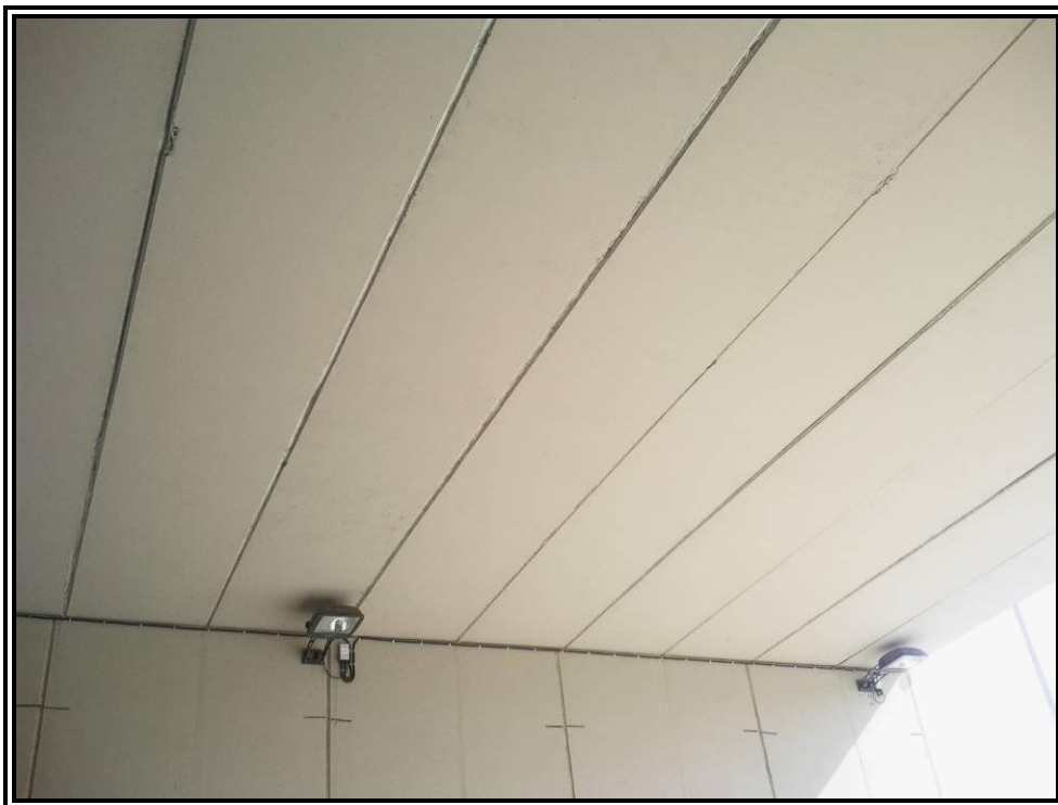
Nº 6.- Vista inferior de la losa mixta.
