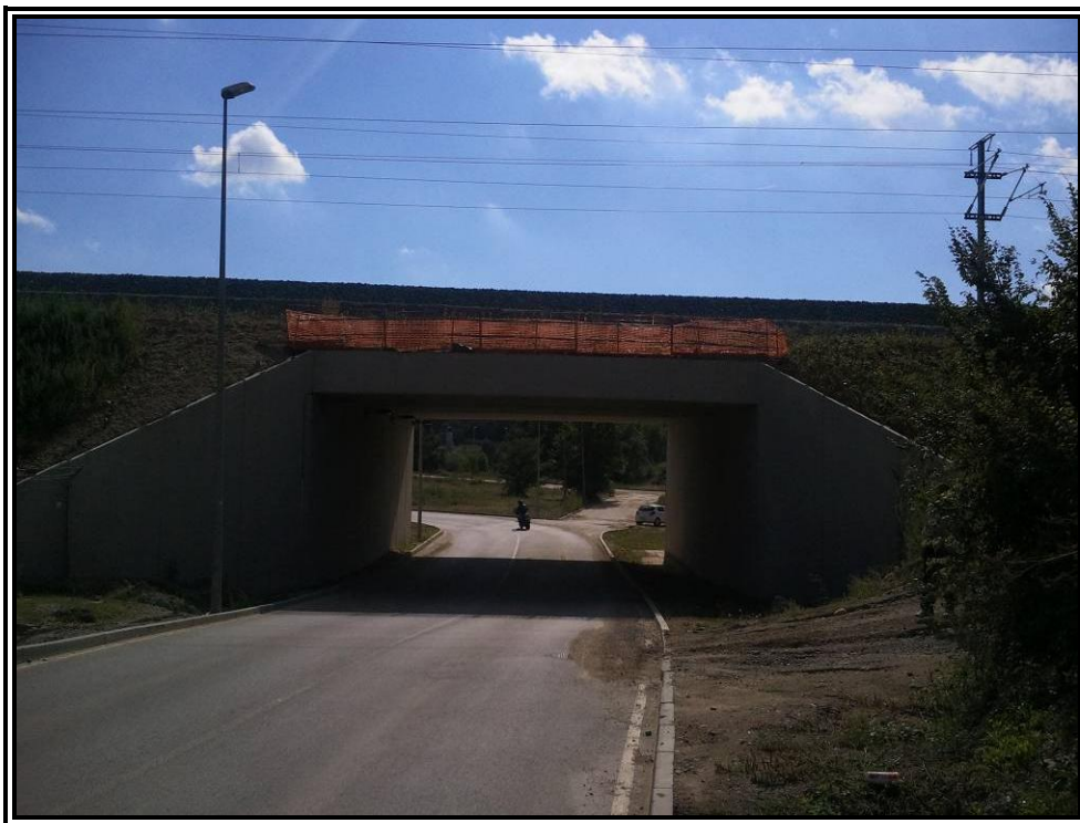
Nº 2.- Alzado izquierdo de la estructura.
