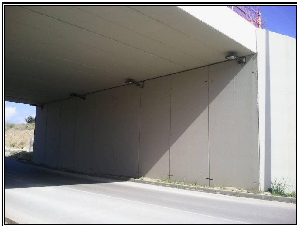
Nº 4.-Hastial derecho de la estructura.
