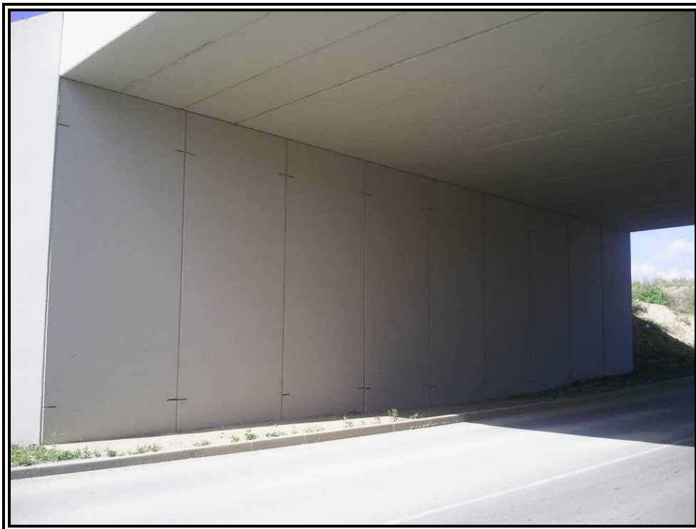
Nº 5.- Hastial izquierdo de la estructura.
