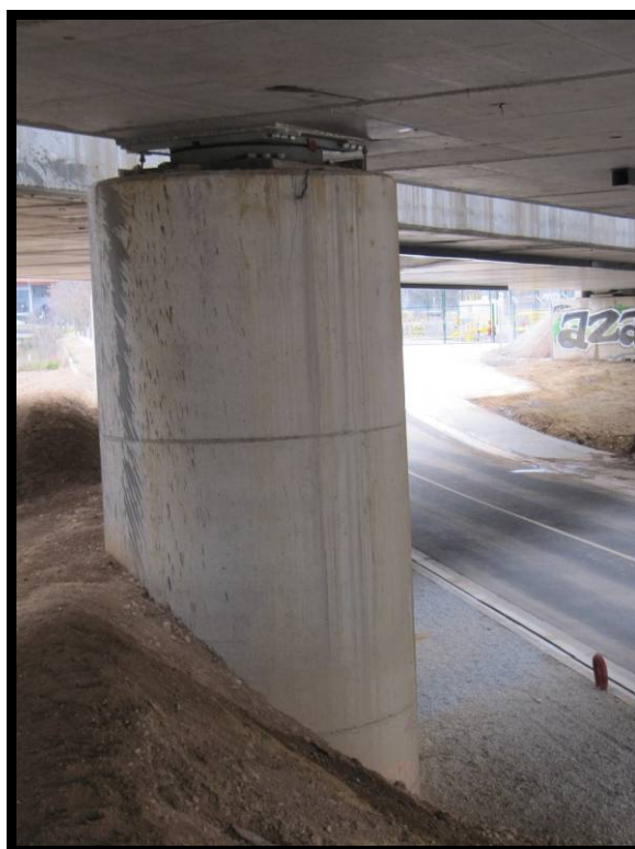
Detalle fuste derecho, pila 1.
