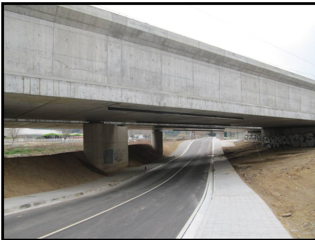
Carretera bajo el vano 1.
