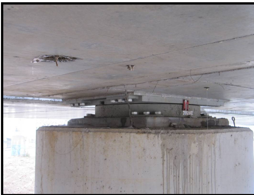
Detalle apoyo tipo pot sobre pila.
