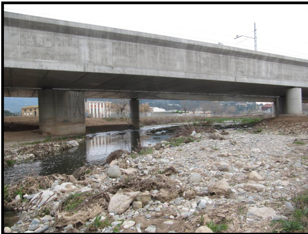
Cauce bajo el vano 3.
