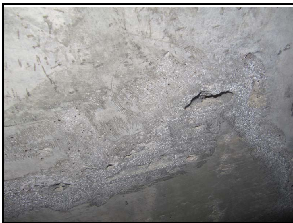
Coquera, plataforma, viga derecha vano 2.
