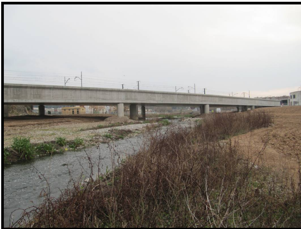
Alzado izquierdo, vista hacia el estribo 1.
