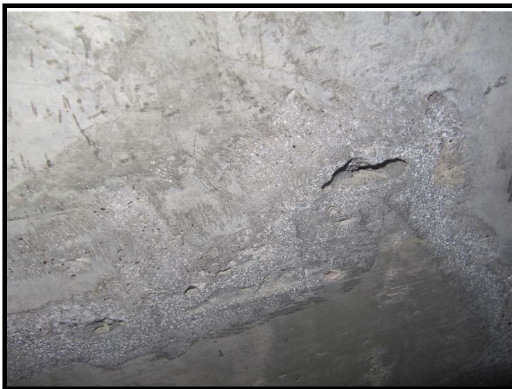
Coquera, plataforma, viga derecha vano 2.
