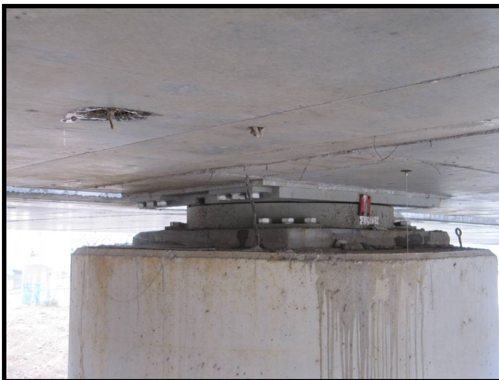
Detalle apoyo tipo pot sobre pila.
