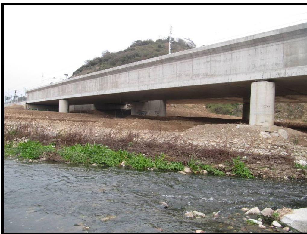
Alzado izquierdo, vista hacia el estribo 2.
