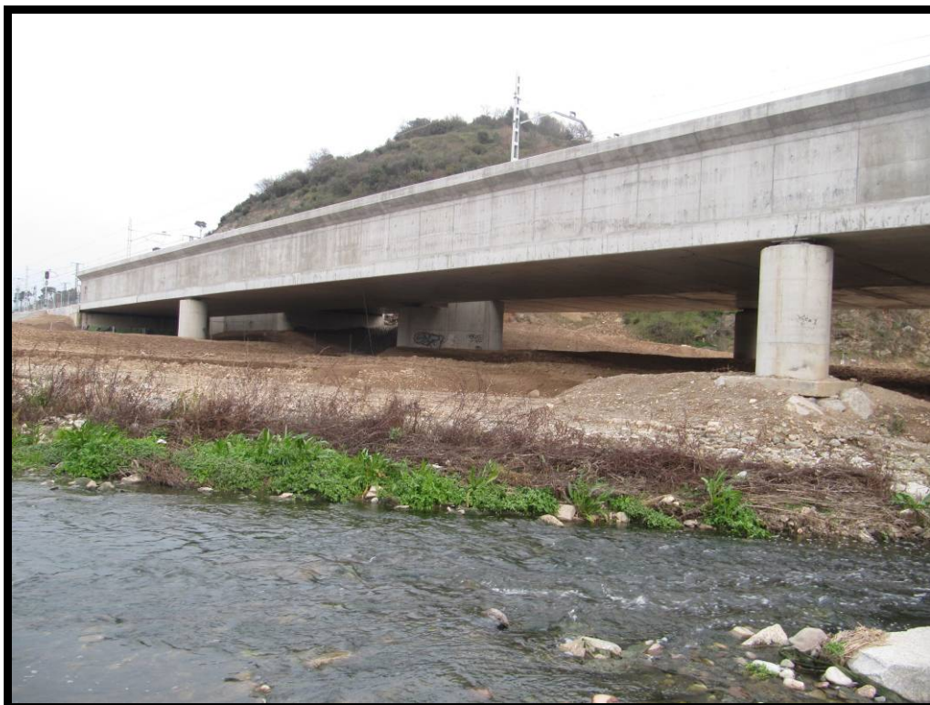
Alzado izquierdo, vista hacia el estribo 2.
