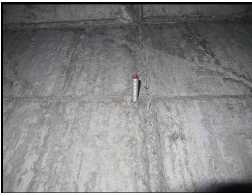
Barra en paramento, plataforma, vano 3 viga izquierda.
