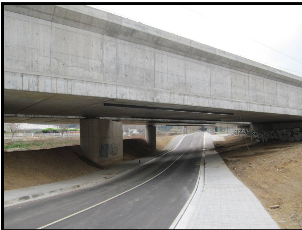
Carretera bajo el vano 1.
