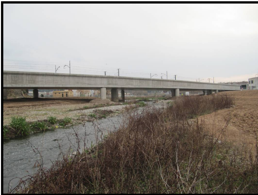
Alzado izquierdo, vista hacia el estribo 1.
