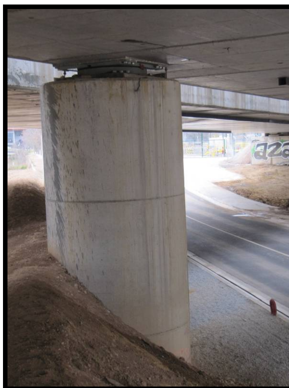
Detalle fuste derecho, pila 1.
