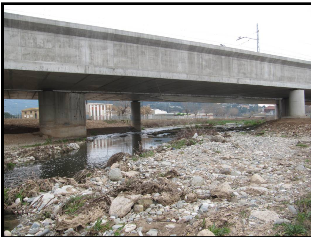
Cauce bajo el vano 3.
