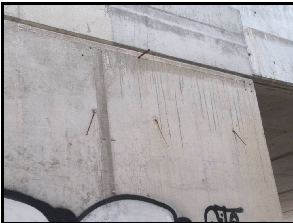
Barras de montaje vistas, muro lateral derecho estribo 1.
