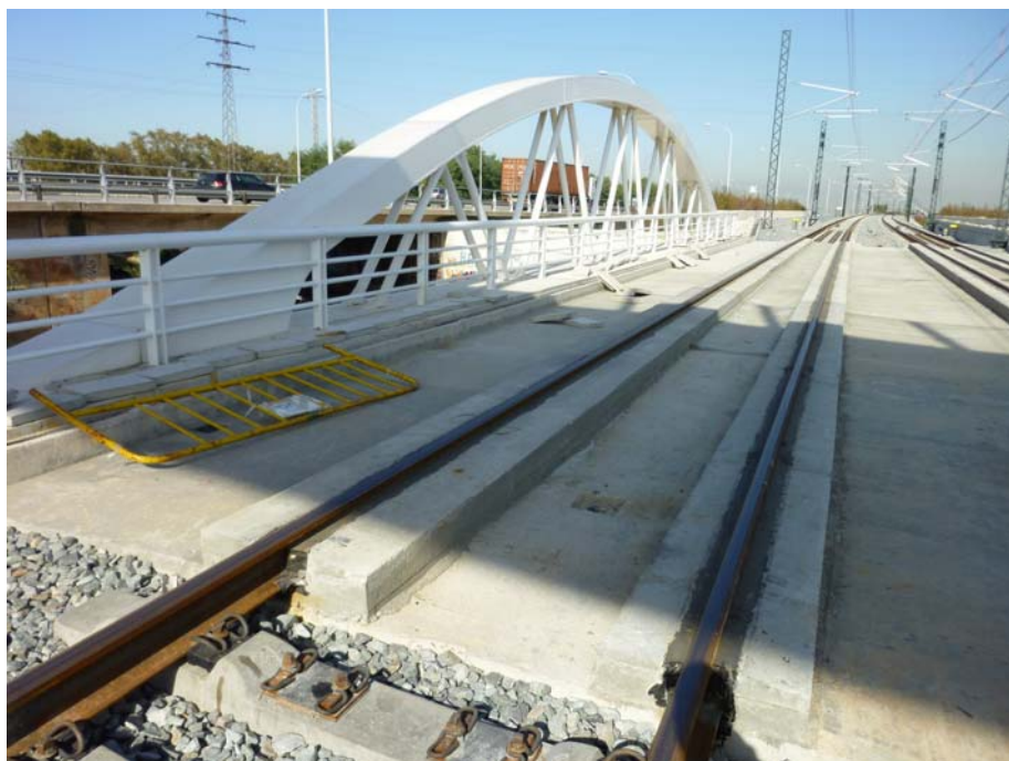
FOTOGRAFIA N° 8: Vista del lado izquierdo de la plataforma
