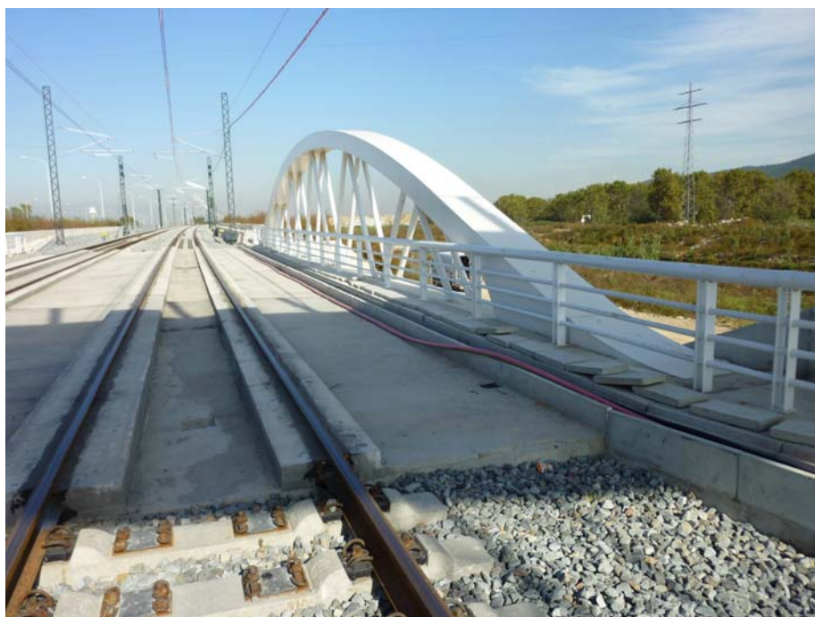
FOTOGRAFIA N° 7: Vista del lado derecho de la plataforma
