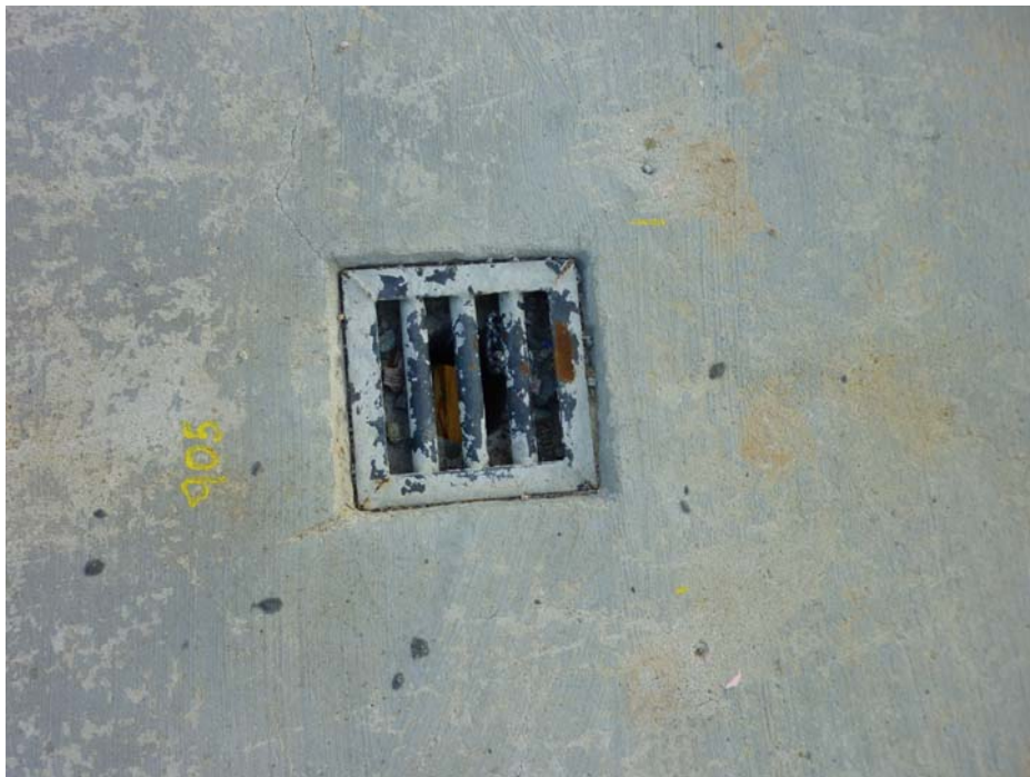
FOTOGRAFIA N° 11: Vista de una de las rejillas de protección de los imbornales
