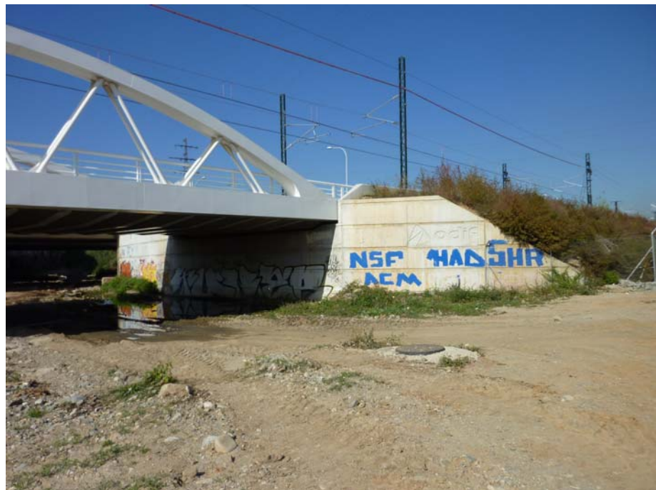
FOTOGRAFIA N° 10: Vista del estribo de salida
