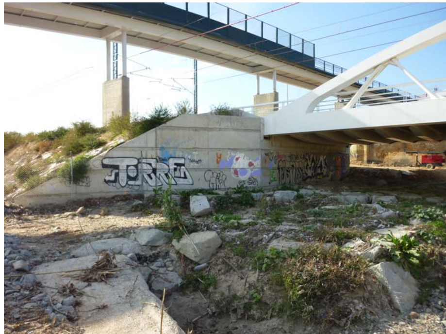
FOTOGRAFIA N° 9: Vista del estribo de entrada
