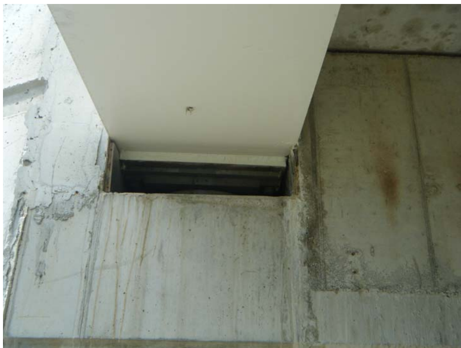
FOTOGRAFIA N° 11: Vista de uno de los aparatos de apoyo
