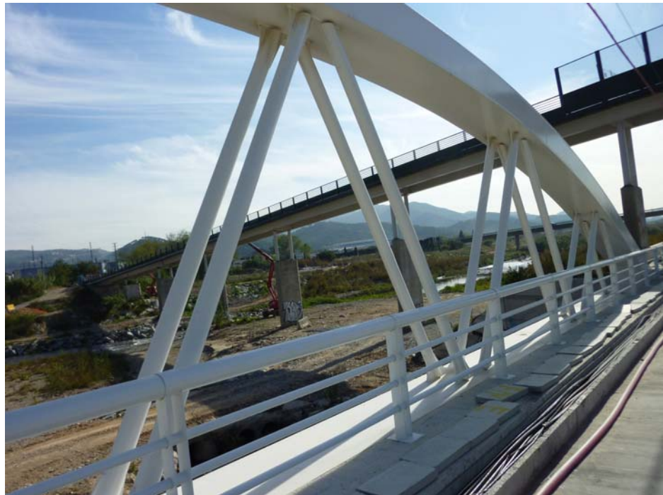
FOTOGRAFIA N° 11: Detalle de las péndolas trianguladas
