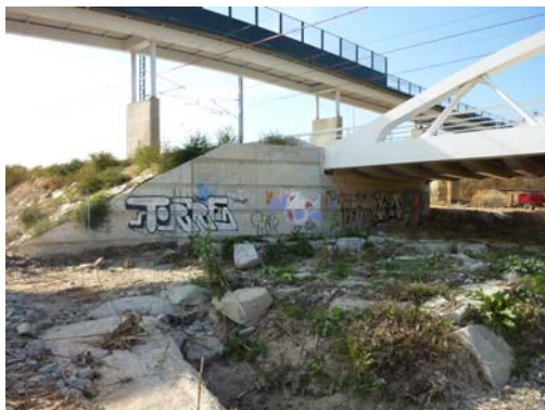
Fotografía nº 5. Estribo de entrada
