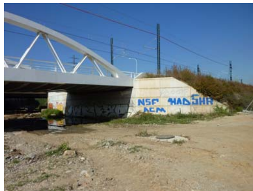
Fotografía nº 6. Estribo de salida
