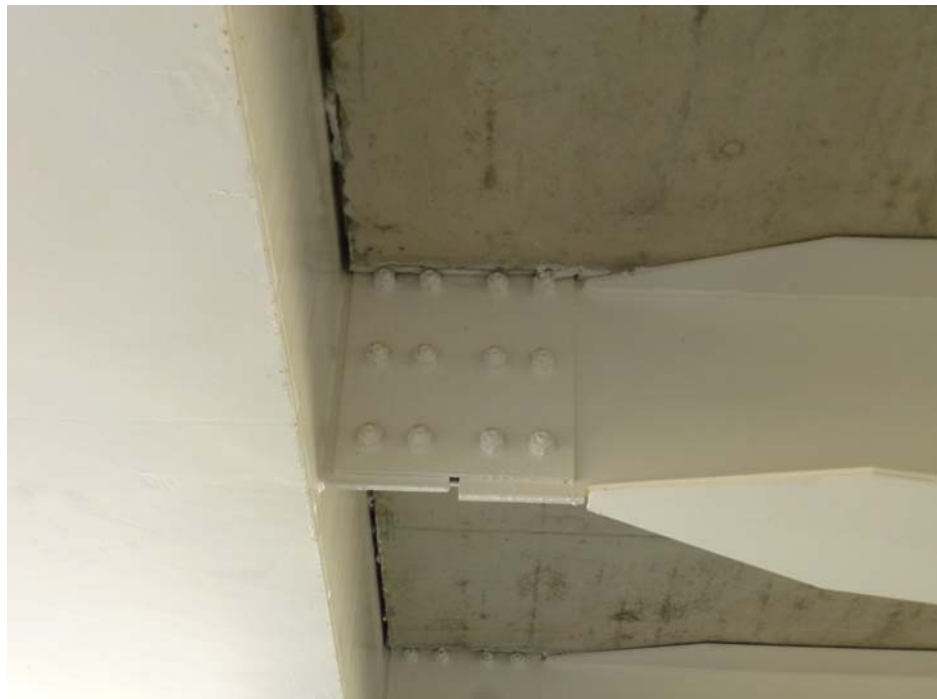
FOTOGRAFIA N° 12: Detalle de conexión entre las vigas transversales y el cordón inferior
