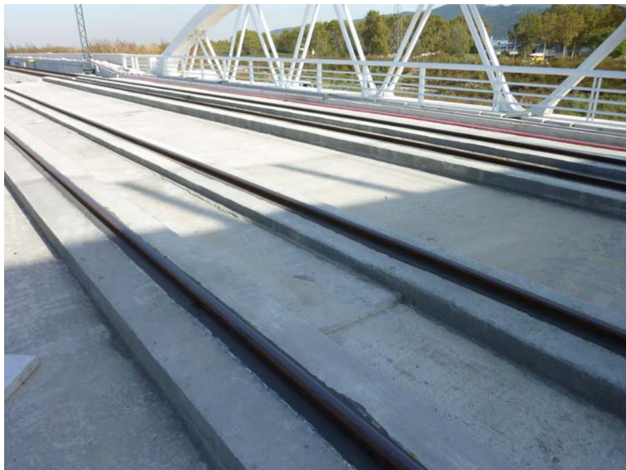
FOTOGRAFIA N° 6: Vista del material de vía
