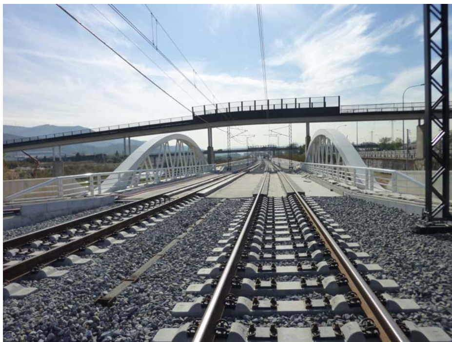
FOTOGRAFIA N° 2: Vista superior del tablero dirección Barcelona
