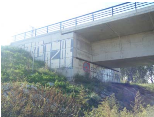
Fotografía nº 1: Protección de escollera en el estribo nº 1
