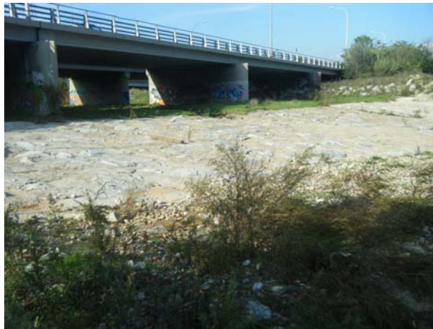
Fotografía n° 3: Protección de escollera aguas arriba del cauce
