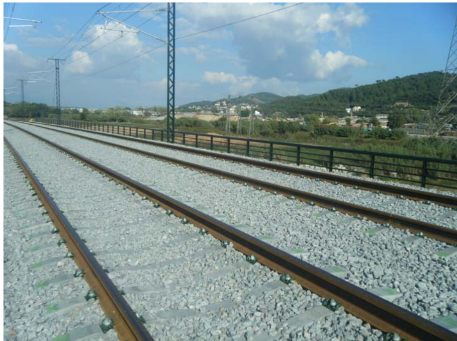
FOTOGRAFIA N° 6: Vista del material de vía
