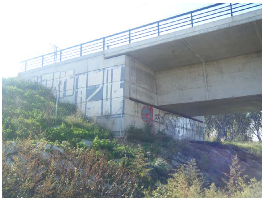
FOTOGRAFIA N° 10: Vista del estribo de entrada
