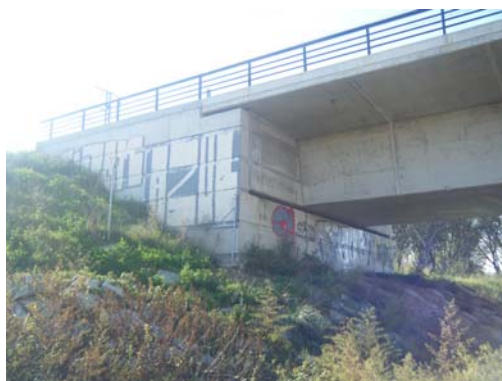
Fotografía nº 5. Estribo de entrada
