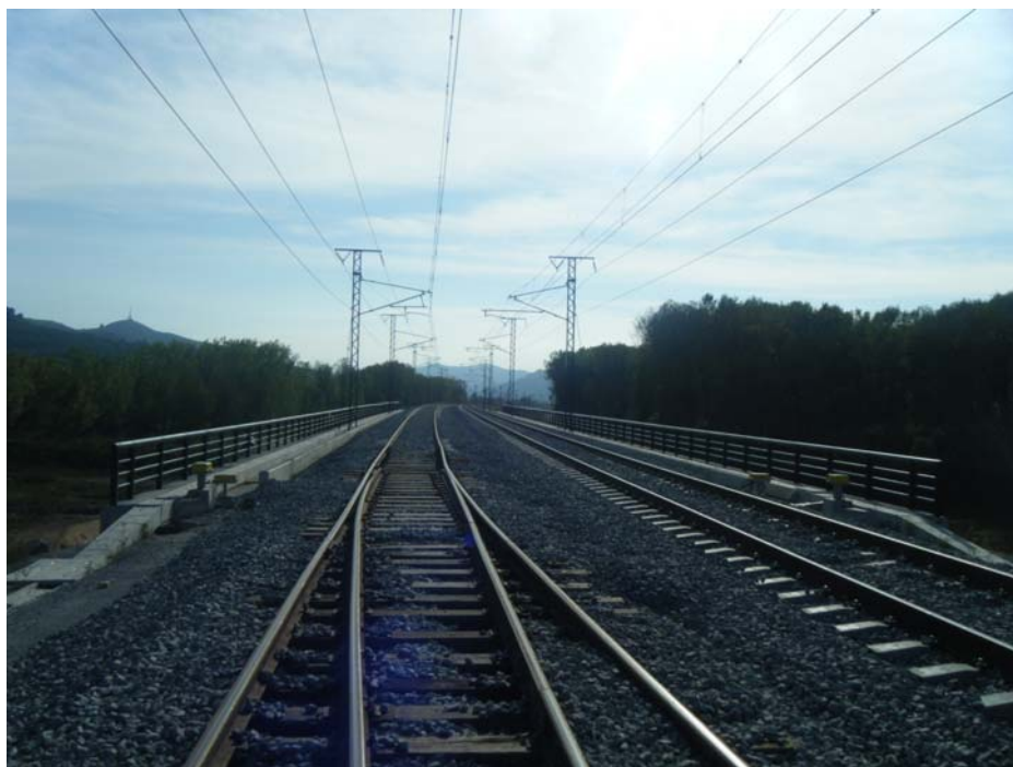
FOTOGRAFIA N° 2: Vista superior del tablero dirección Barcelona
