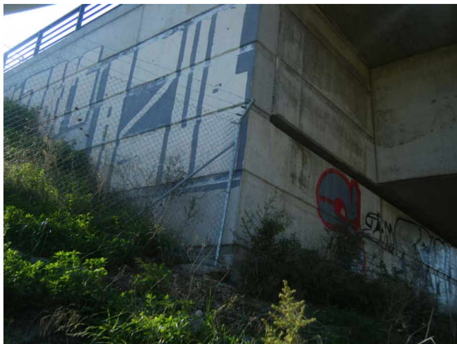
FOTOGRAFIA N° 19: Pintadas la aleta derecha del estribo de entrada
