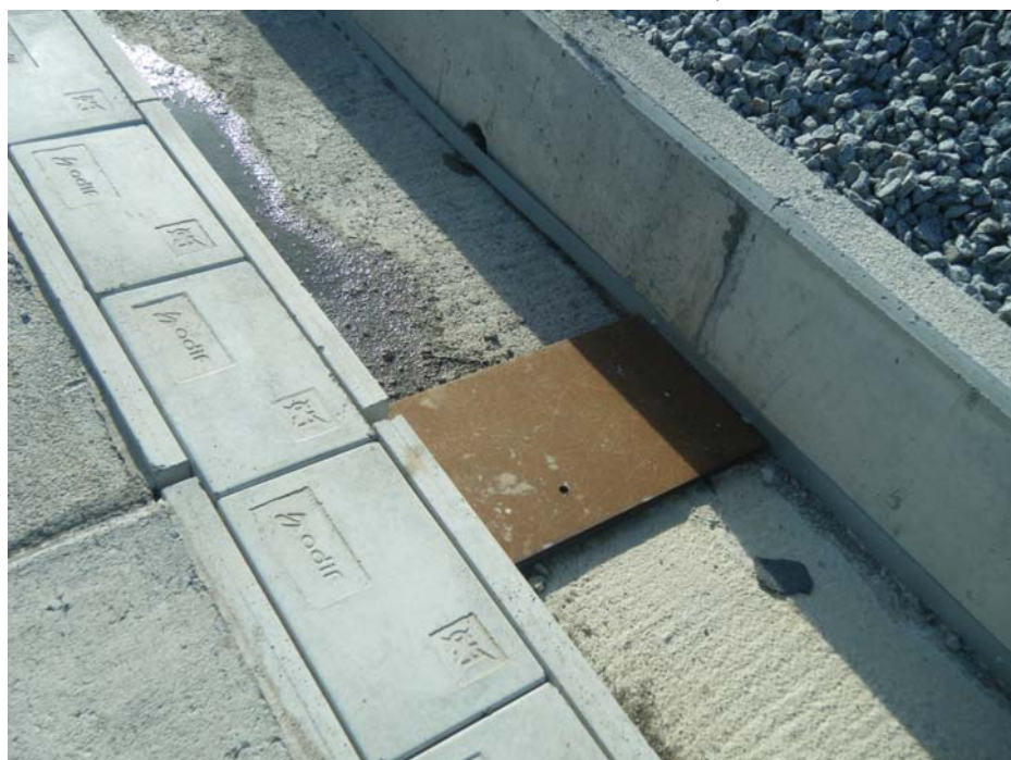
FOTOGRAFIA N° 16: Detalle de la junta de dilatación sobre el estribo de salida
