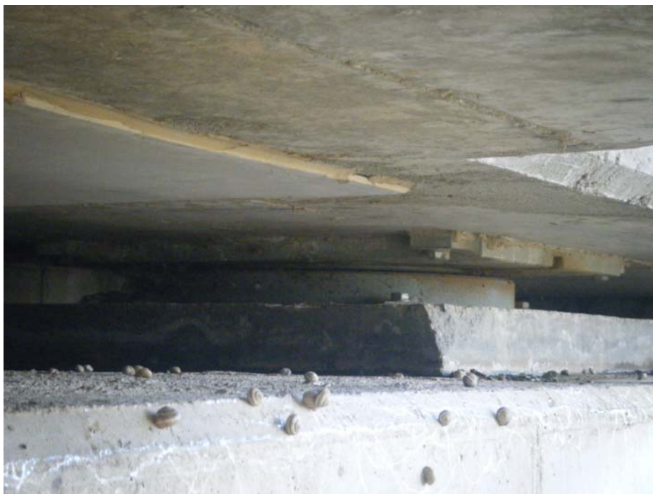
FOTOGRAFIA N° 12: Detalle del tipo de aparato de apoyo empleado
