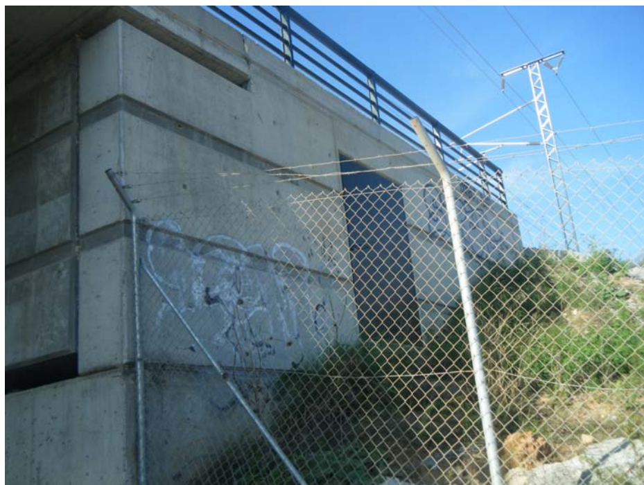
FOTOGRAFIA N° 25: Pintadas en la aleta derecha del estribo de salida
