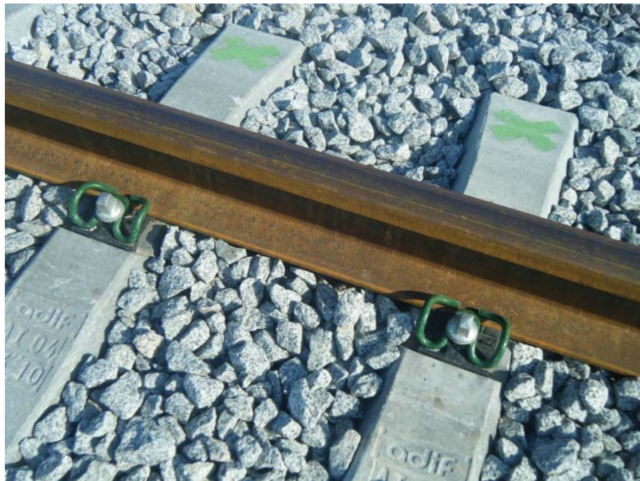
FOTOGRAFIA N° 7: Detalle de sujeción del carril
