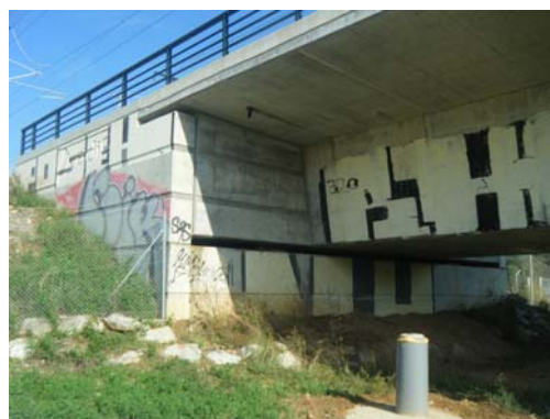
Fotografía nº 6. Estribo de salida
