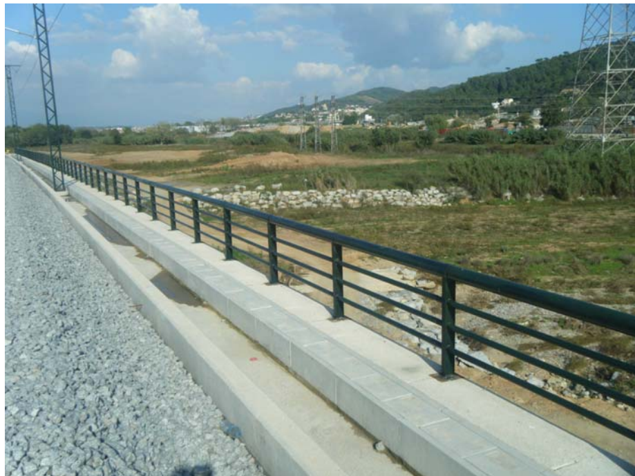
FOTOGRAFIA N° 8: Vista del lado derecho de la plataforma
