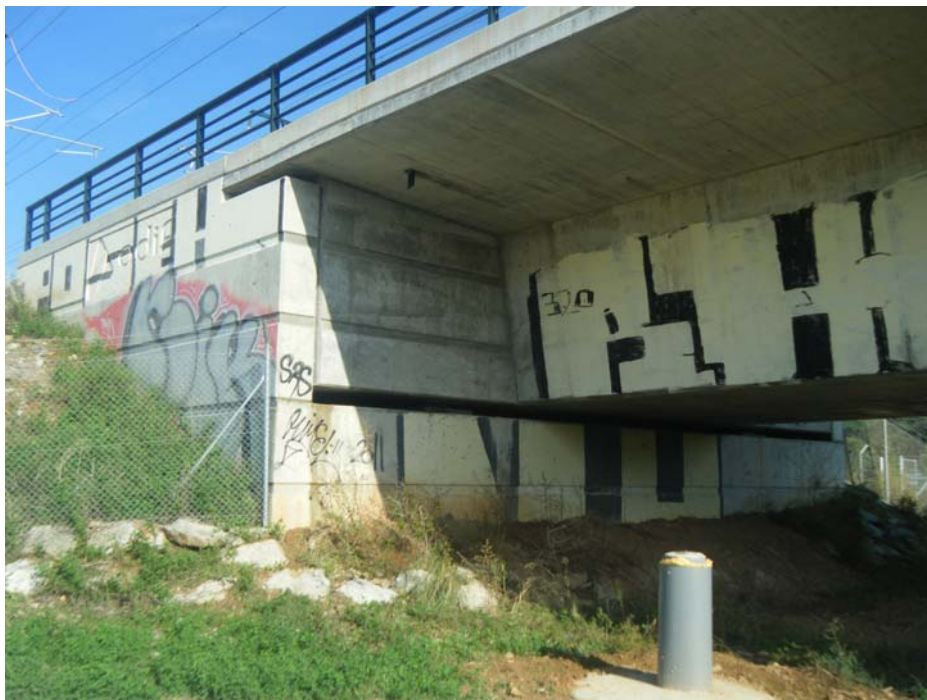
FOTOGRAFIA N° 11: Vista del estribo de salida
