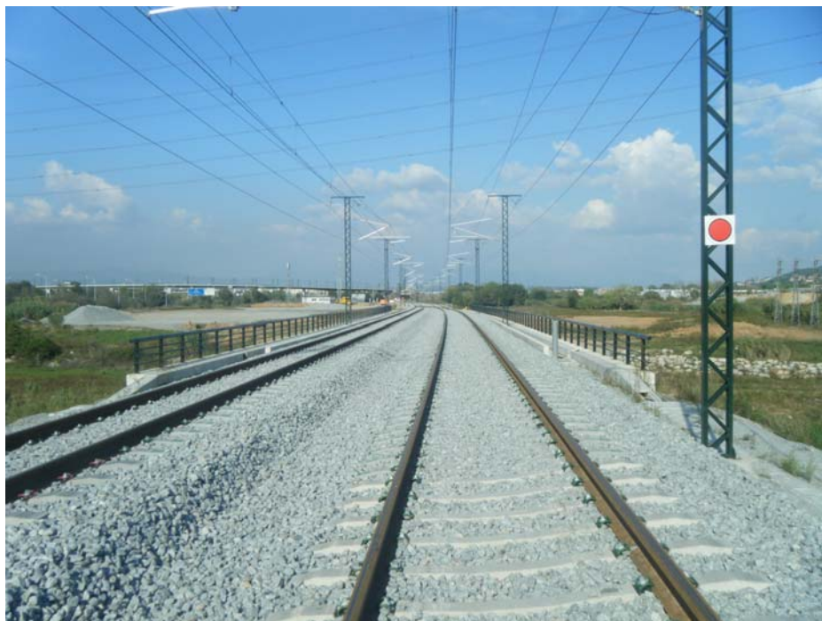
FOTOGRAFIA N° 1: Vista Superior del tablero dirección Figueras
