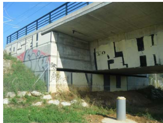
Fotografía nº 2: Protección de escollera en el estribo nº 2
