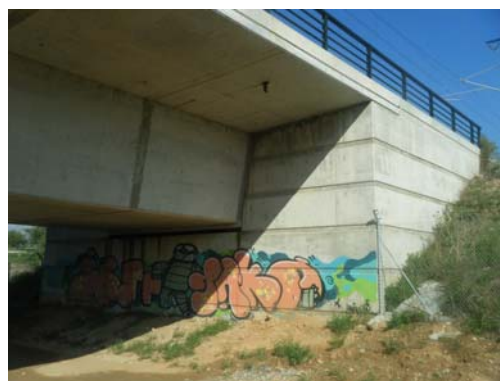
Fotografía nº 6. Estribo de salida
