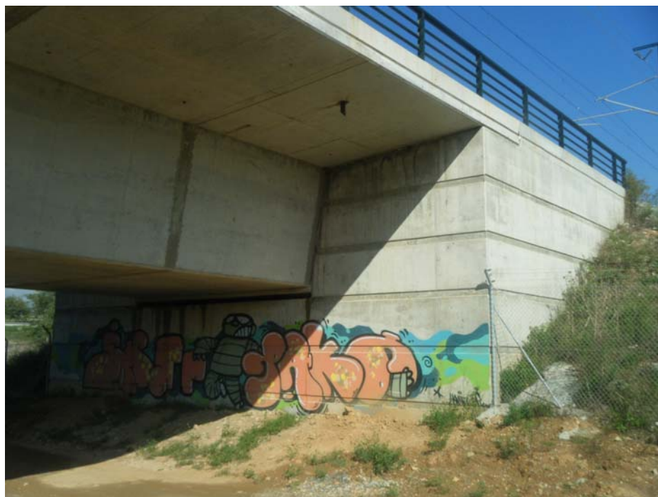
FOTOGRAFIA N° 11: Vista del estribo de salida
