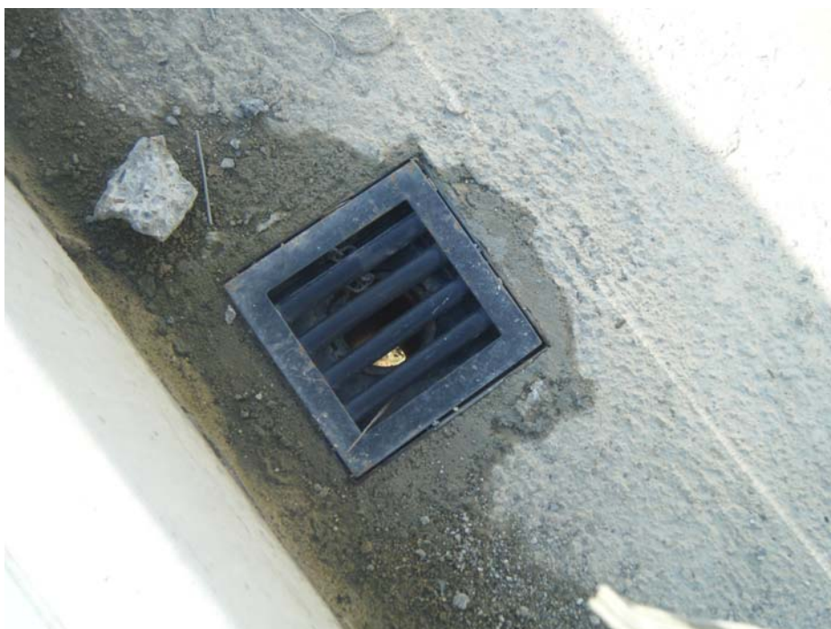
FOTOGRAFIA N° 14: Rejilla de protección empleada en los imbornales
