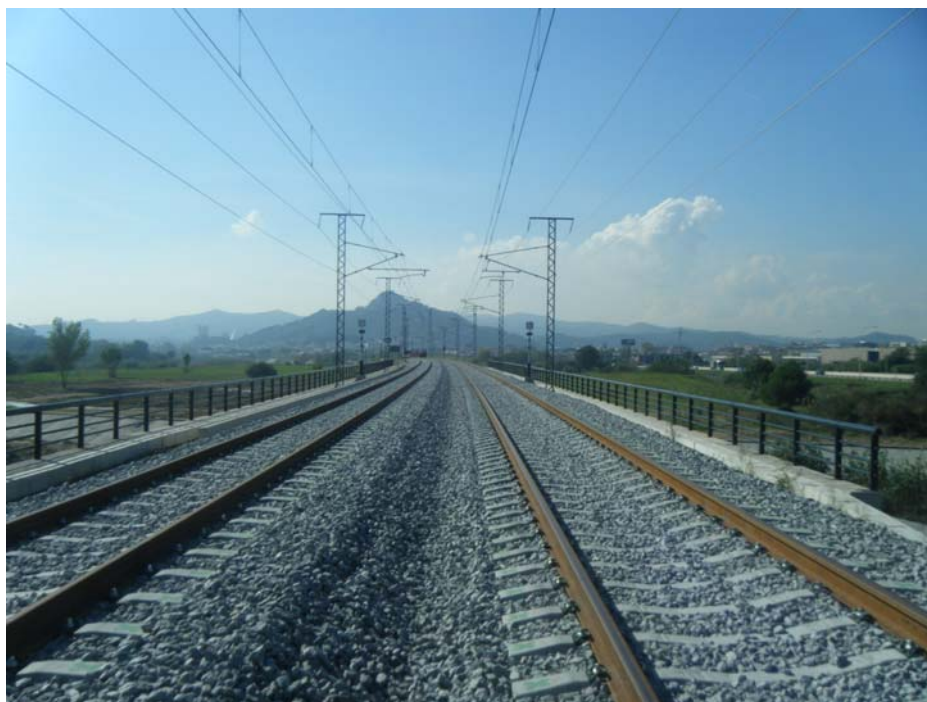
FOTOGRAFIA N° 2: Vista superior del tablero dirección Barcelona
