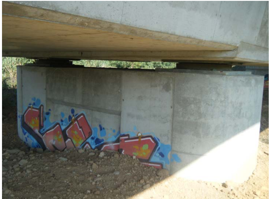
FOTOGRAFIA Nº 21: Pintadas la pila nº 2
