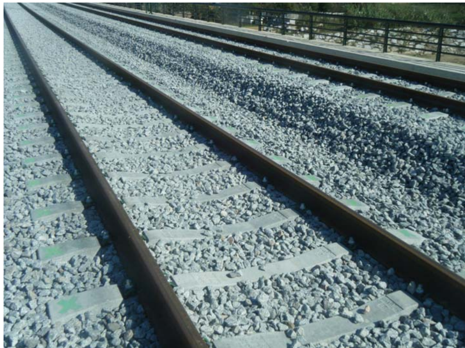
FOTOGRAFIA N° 6: Vista del material de vía
