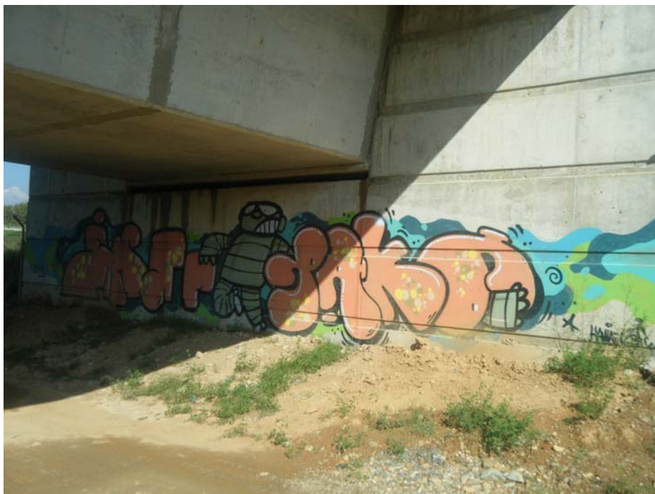
FOTOGRAFIA N° 24: Humedades en el muro de frente del estribo de salida
