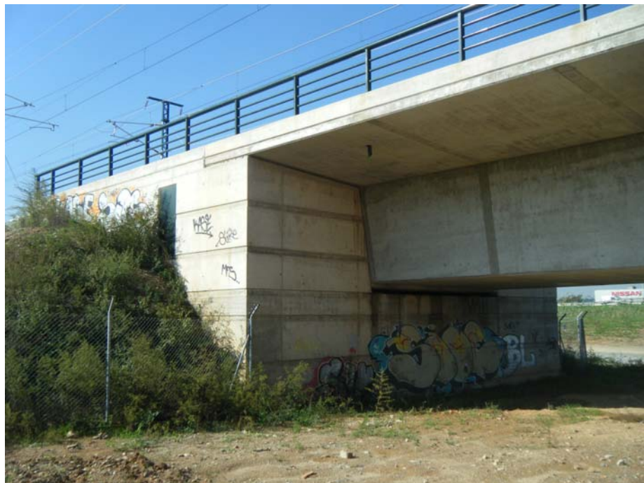
FOTOGRAFIA N° 10: Vista del estribo de entrada
