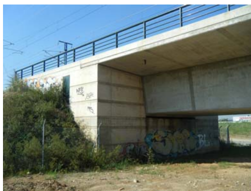
Fotografía nº 5. Estribo de entrada
