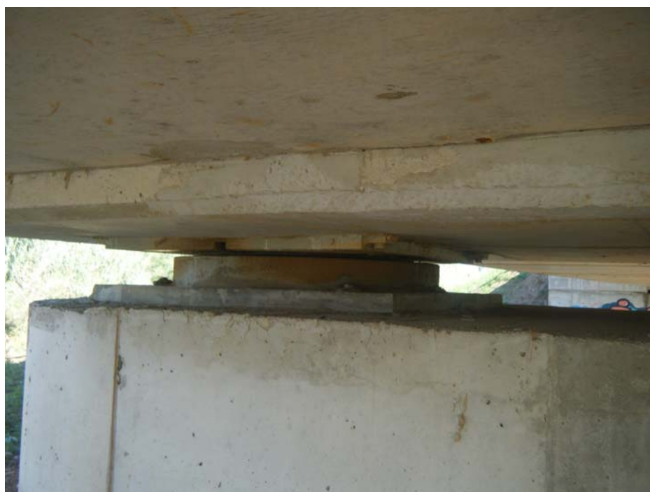
FOTOGRAFIA N° 12: Detalle de aparato de apoyo empleado
