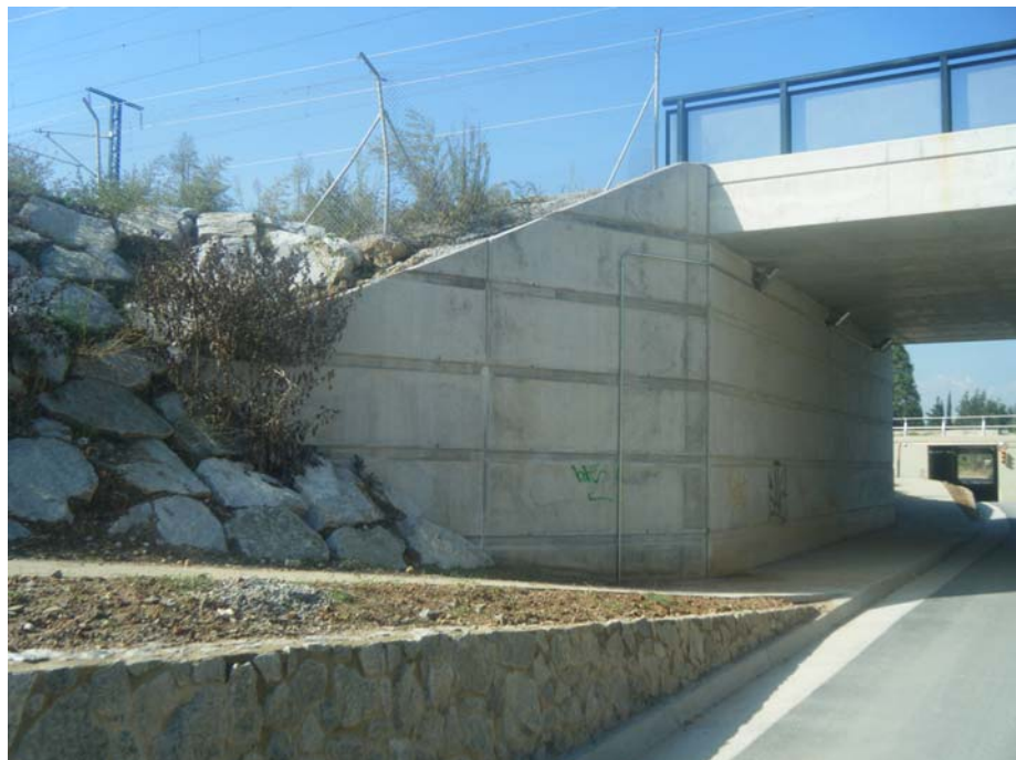
FOTOGRAFIA N° 10: Vista del estribo de entrada
