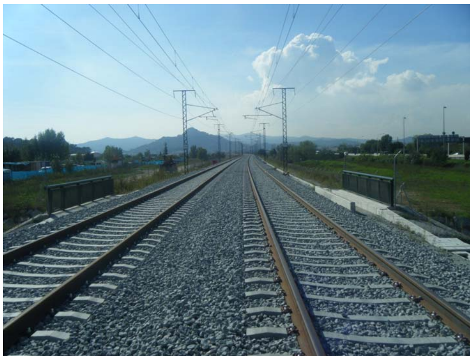
FOTOGRAFIA N° 2: Vista superior del tablero dirección Barcelona
