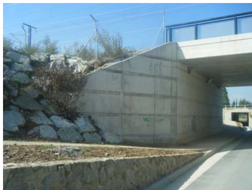
Fotografía nº 5. Estribo de entrada
