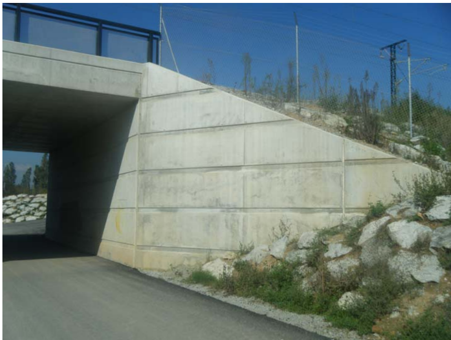
FOTOGRAFIA N° 11: Vista del estribo de salida
