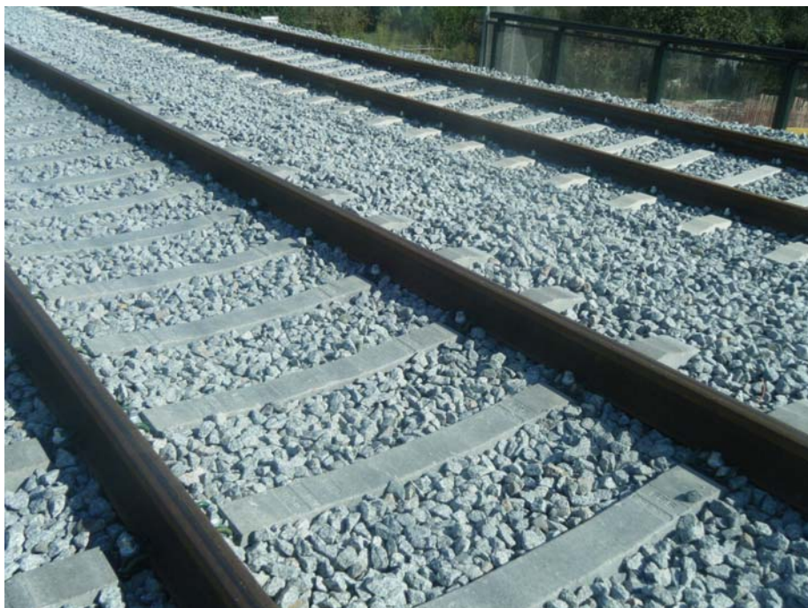
FOTOGRAFIA N° 6: Vista del material de vía
