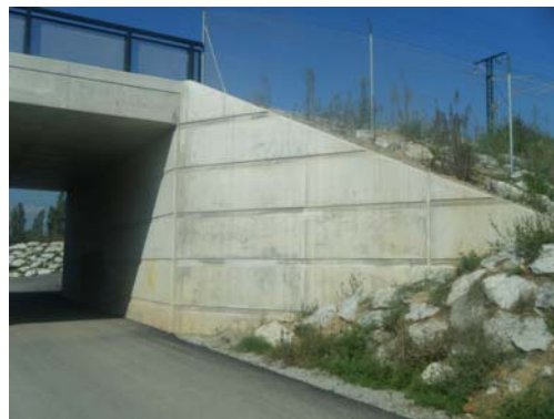
Fotografía nº 6. Estribo de salida
