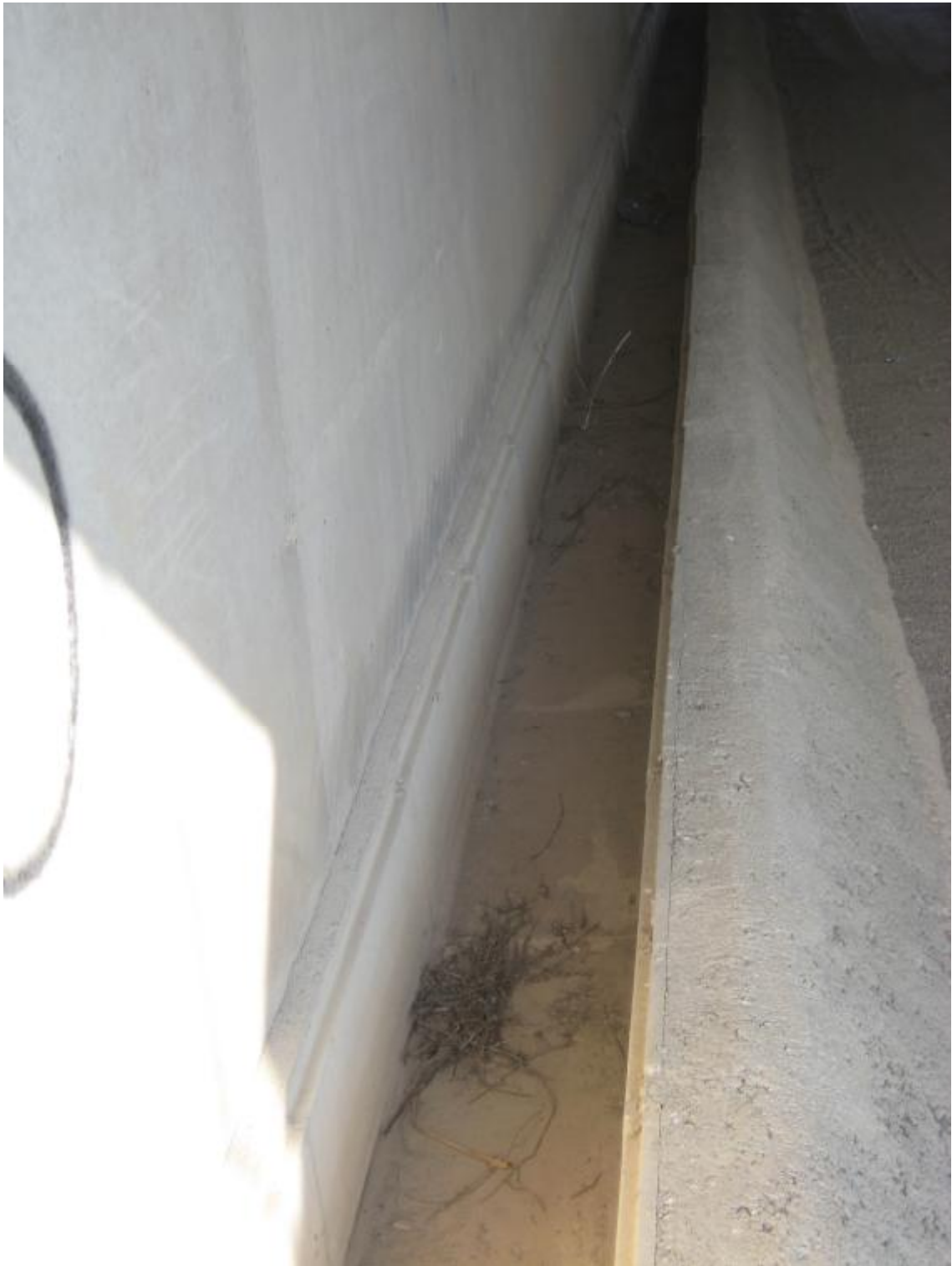
FOTOGRAFIA N°10: Vista de la canalización de aguas.
