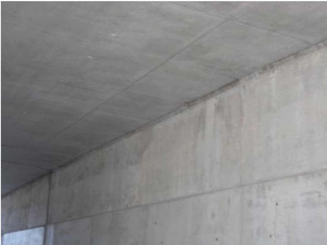
FOTOGRAFIA N°4: Vista lateral derecha.
