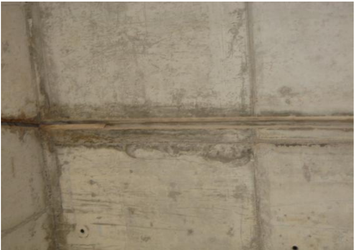
FOTOGRAFIA N°12: Detalle de la unión entre marcos.
