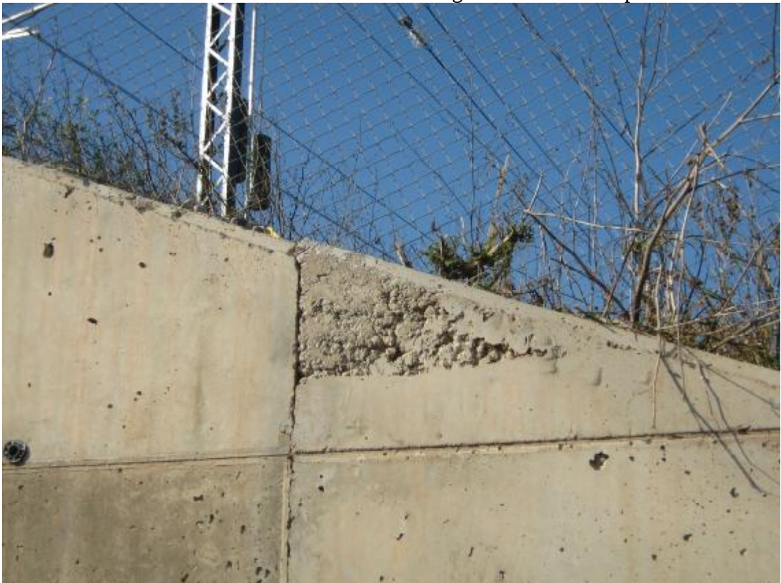
FOTOGRAFIA N°14: Detalle de nido de grava en una de las aletas.
