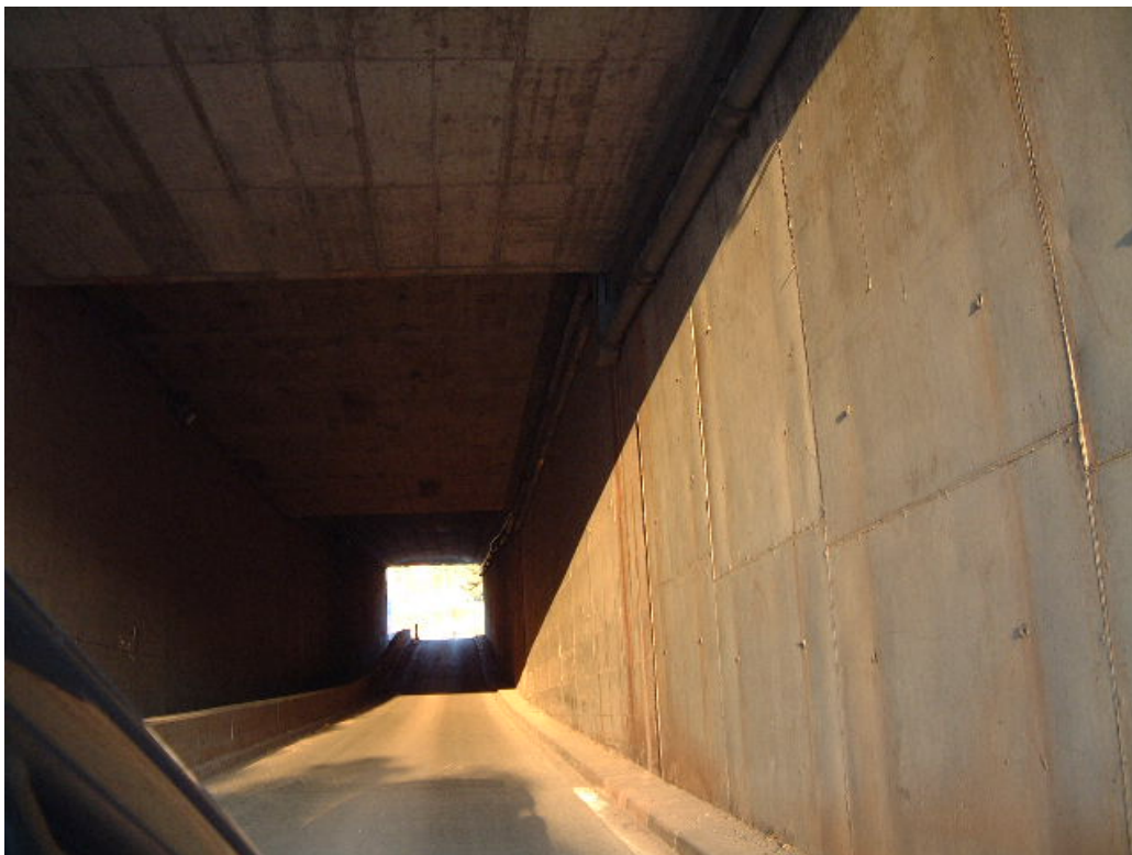
Fotografía 4: Vista inferior tablero
