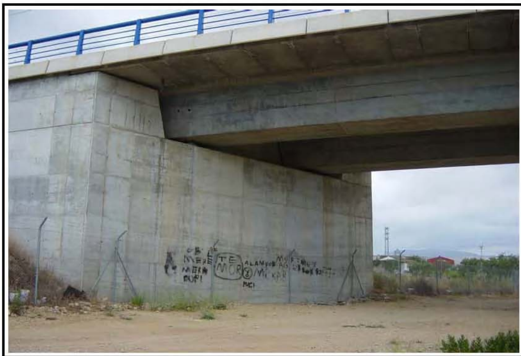
Foto 6: Vista del estribo de salida
