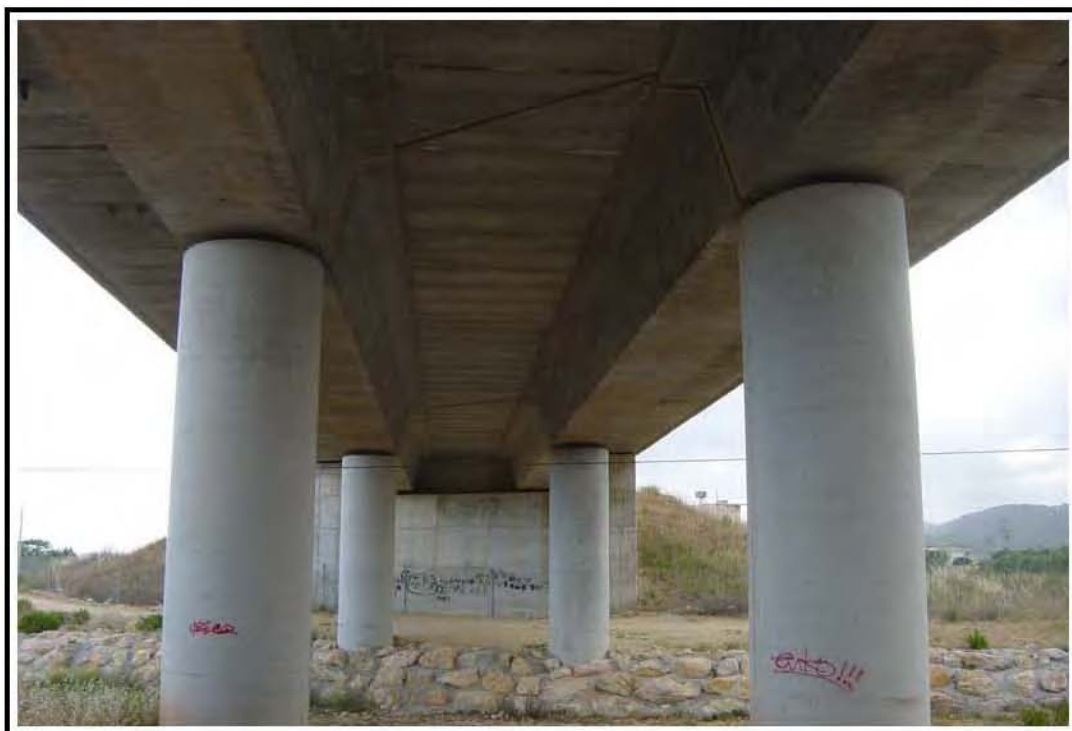
Foto 4: Vista inferior del tablero
