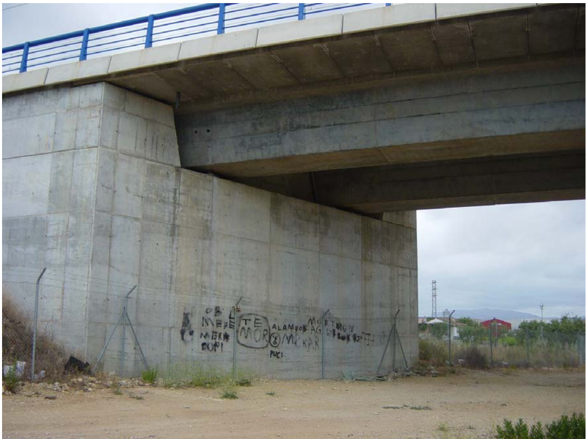
FOTOGRAFIA N°6: Estribo de salida.
