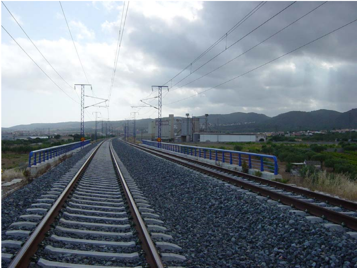
FOTOGRAFIA N°3: Vista superior de entrada.
