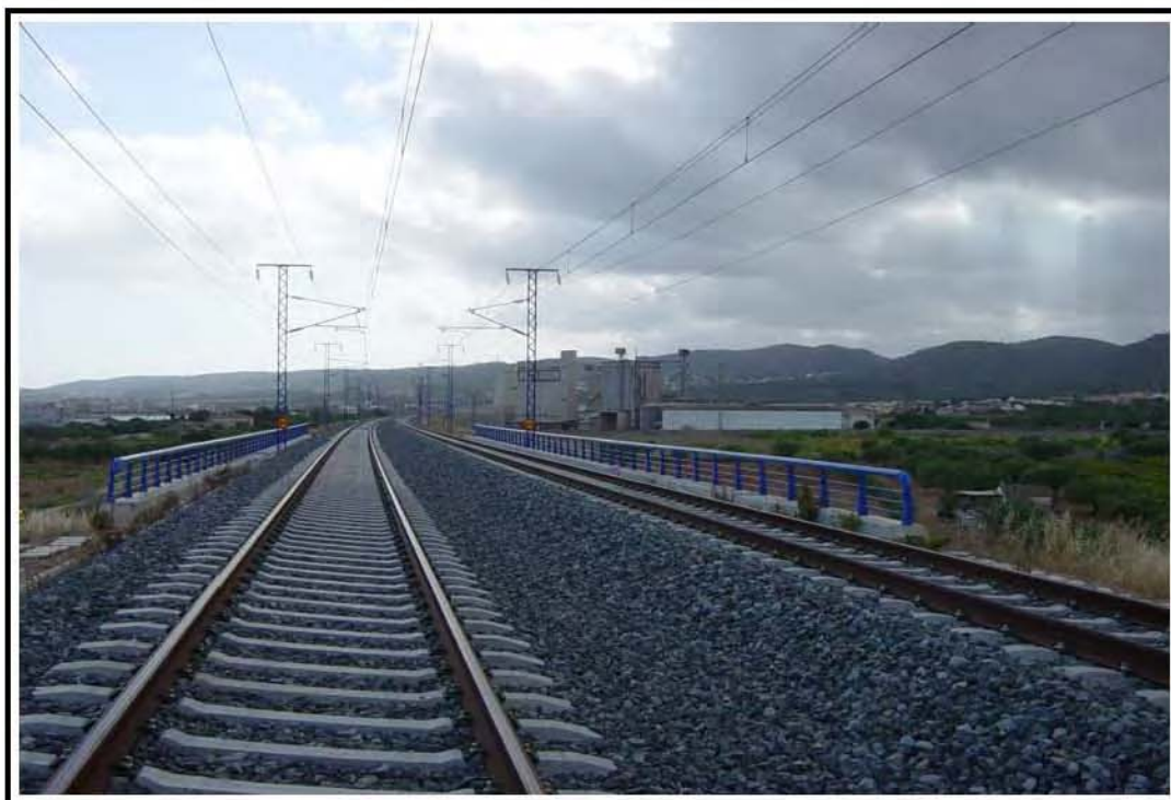
Foto 2: Vista superior del tablero desde la entrada
