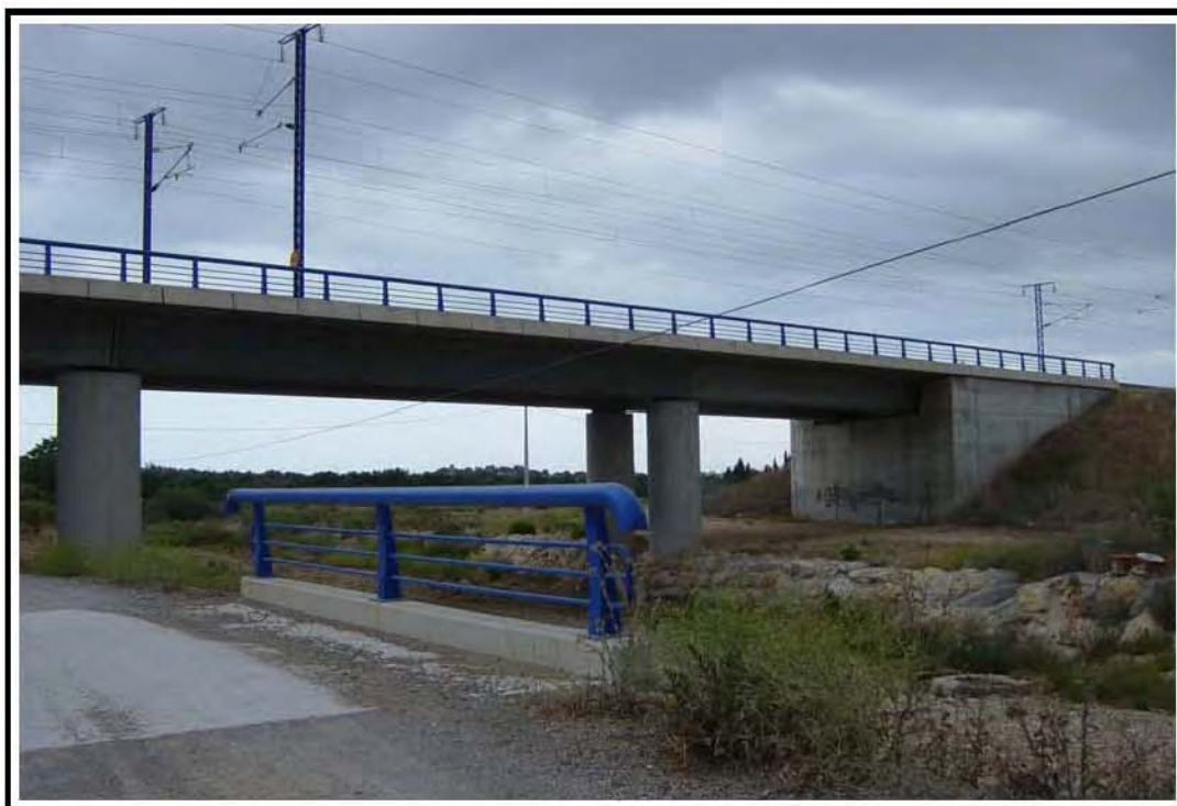
Foto 1: Vista general de la estructura
