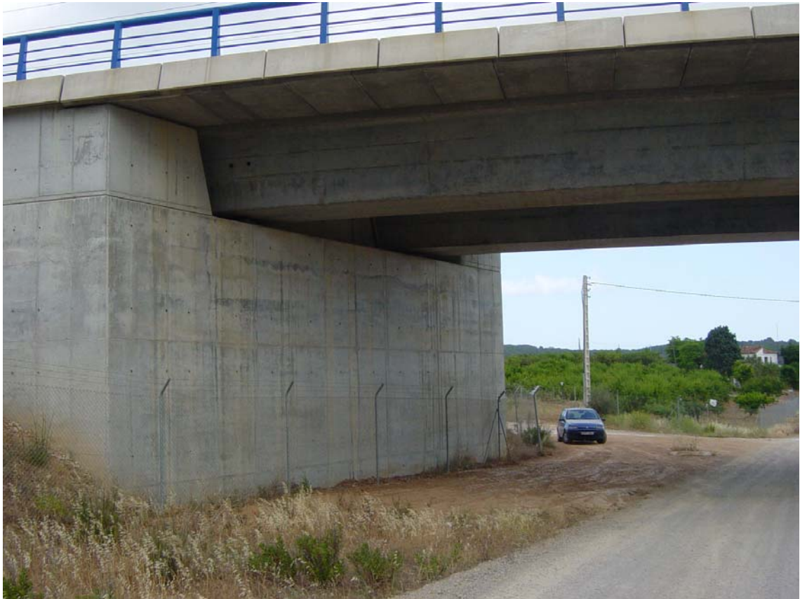
FOTOGRAFIA N°5: Estribo de entrada.
