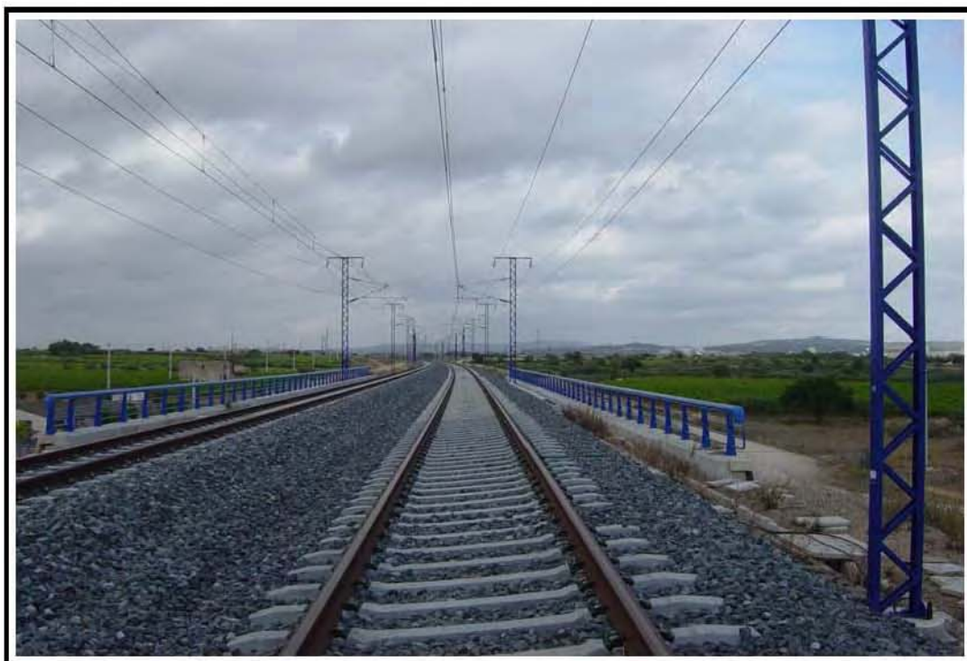
Foto 3: Vista superior del tablero desde la salida
