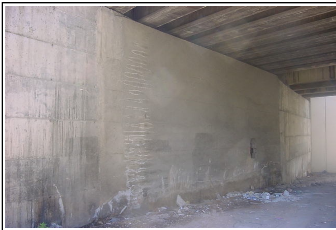
Foto 3: Estribo de salida
