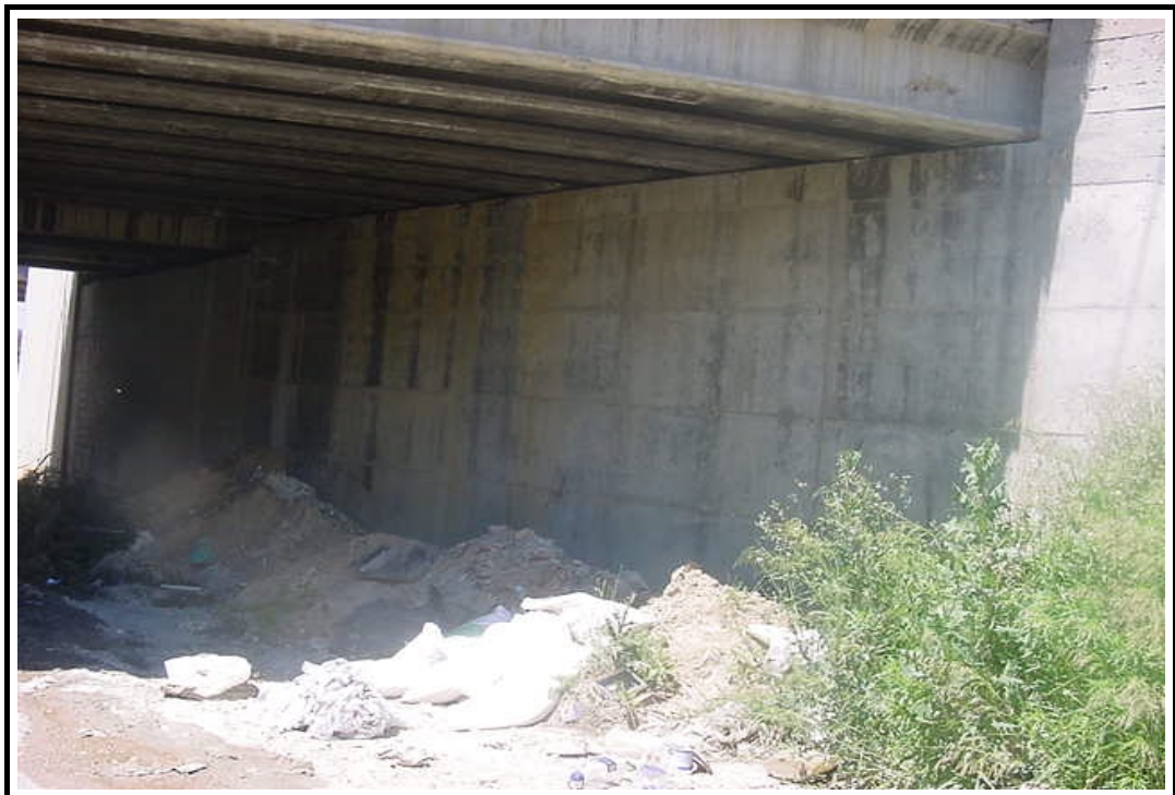
Foto 2: Vista general del estribo de entrada
