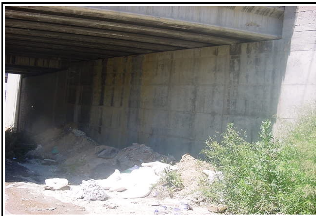
Foto 2: Estribo de entrada
