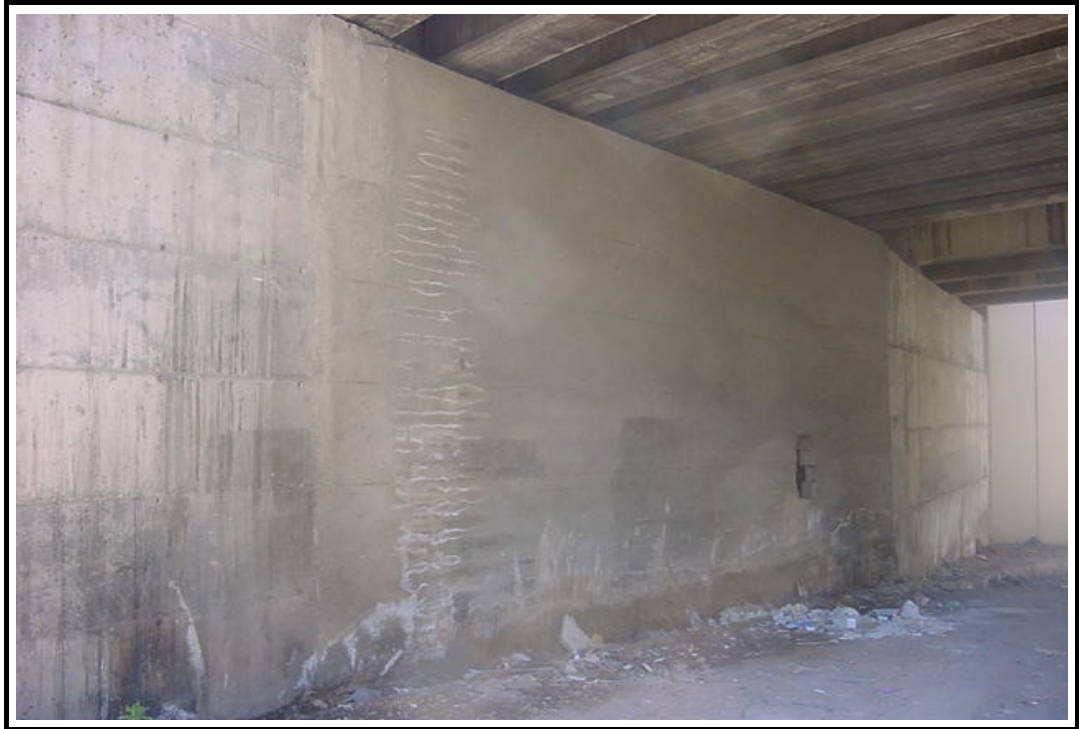
Foto 3: Vista general del estribo de salida
