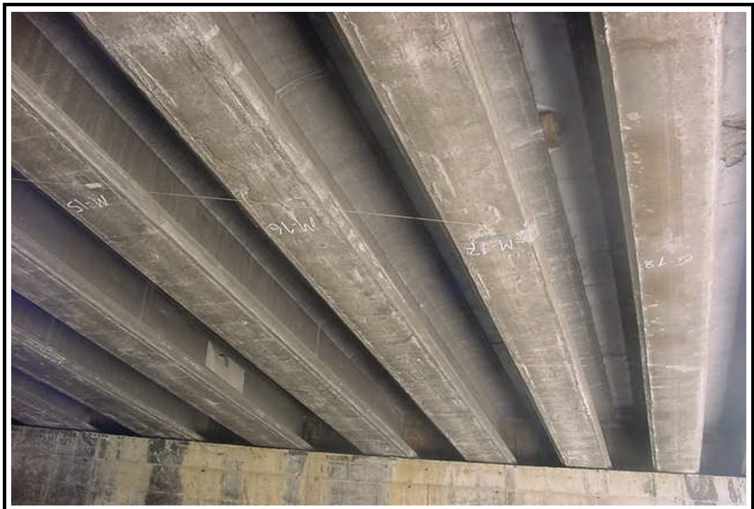
Foto 4: Vista inferior de la estructura
