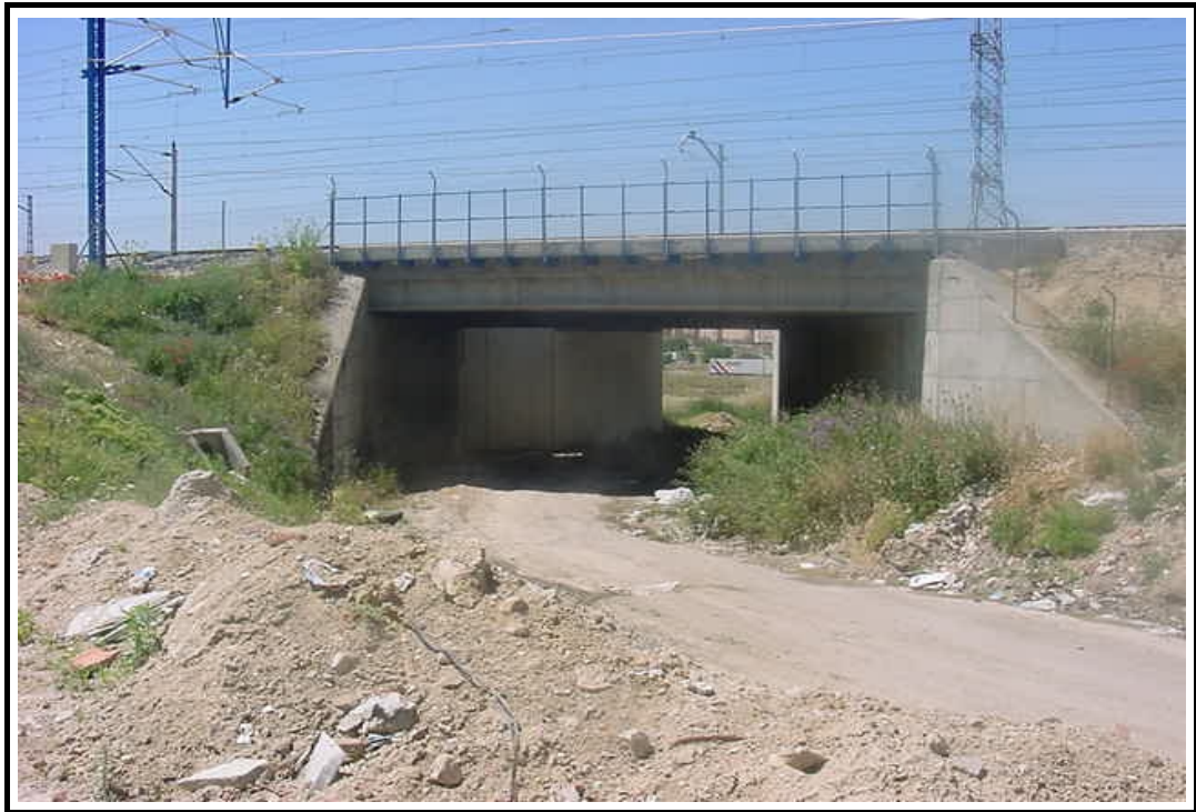
Foto 1: Vista general de la estructura
