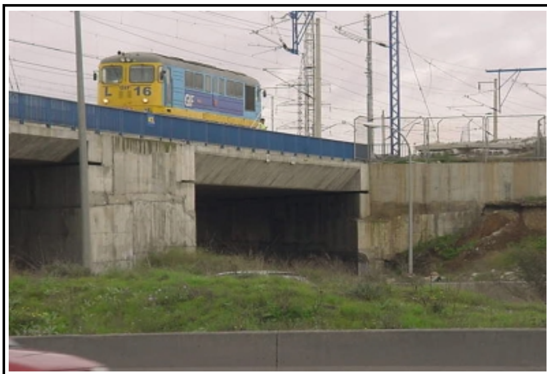
Foto 10: Prueba estática sobre estructura E-2.3
