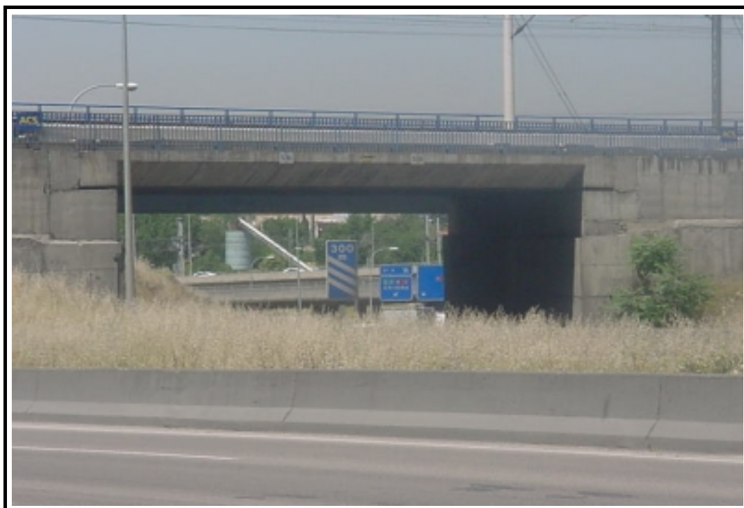
Foto 2: Vista general E-2.2
