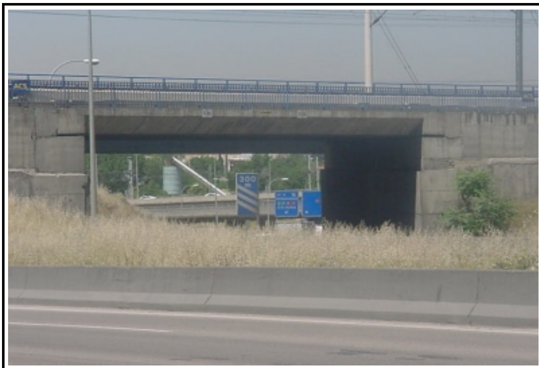
Foto 2: Vista general de la estructura E-2.2
