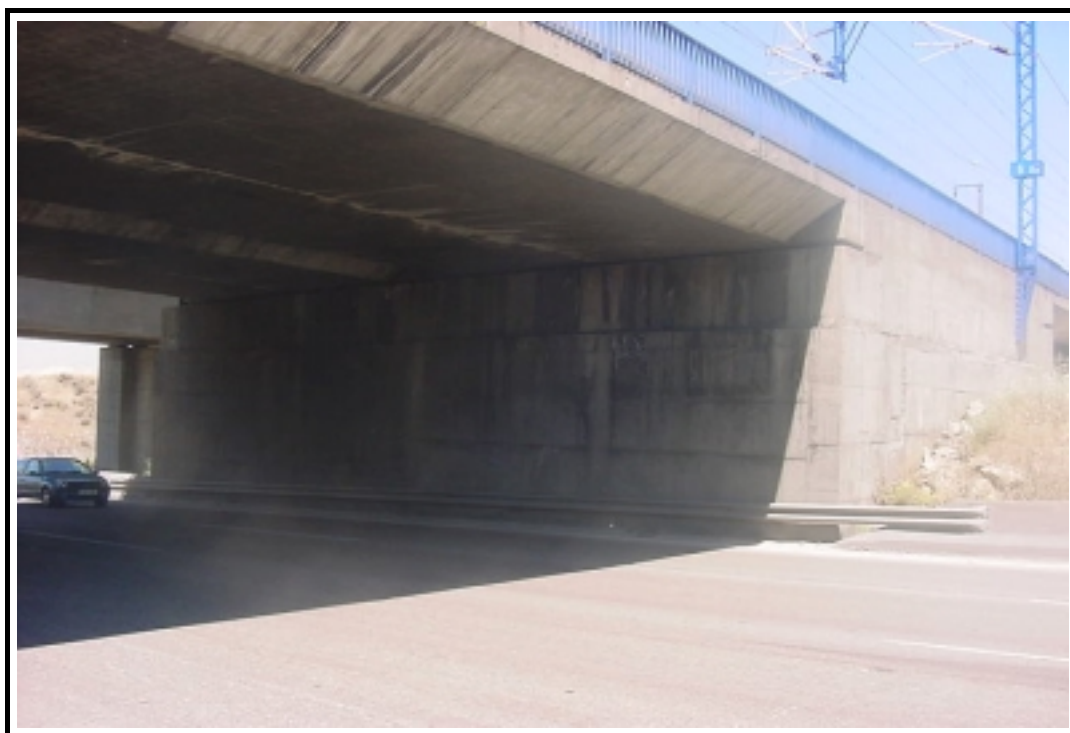
Foto 4: Estribo de entrada E-2.3
