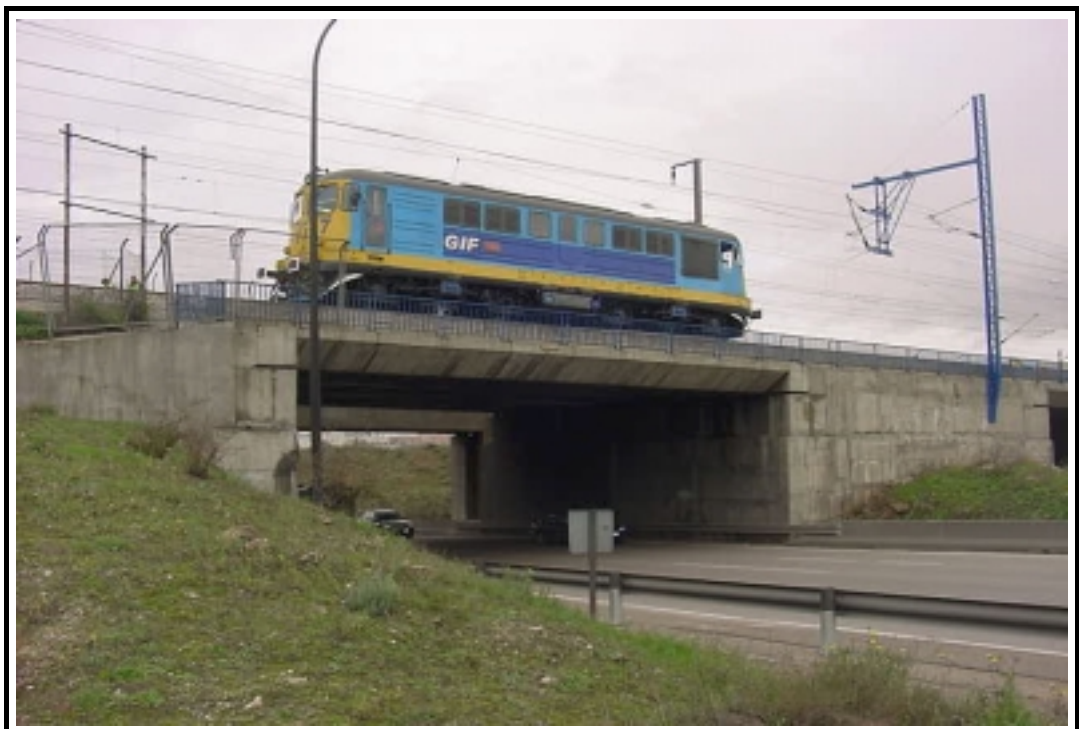
Foto 8: Prueba estática sobre estructura E-2.1
