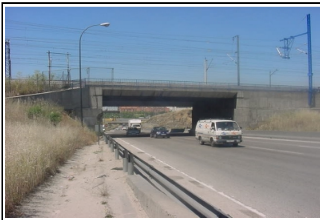
Foto 3: Vista general E-2.3
