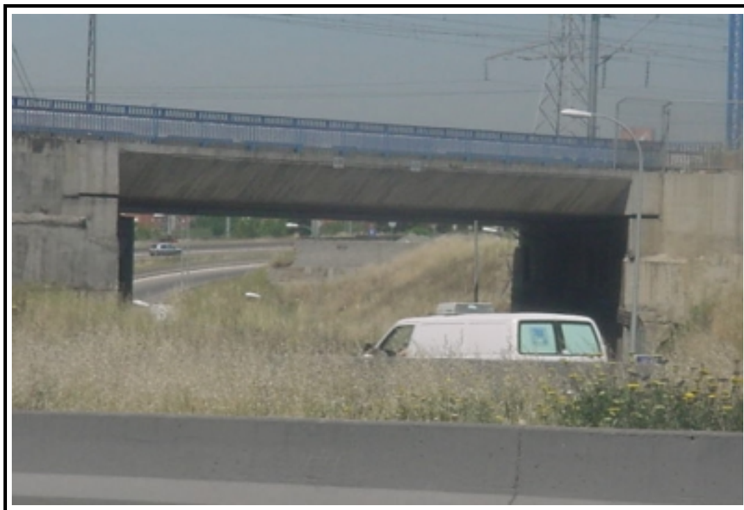
Foto 3: Vista general de la estructura E-2.3
