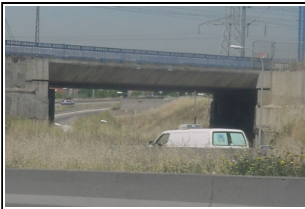
Foto 1: Vista general E-2.1
