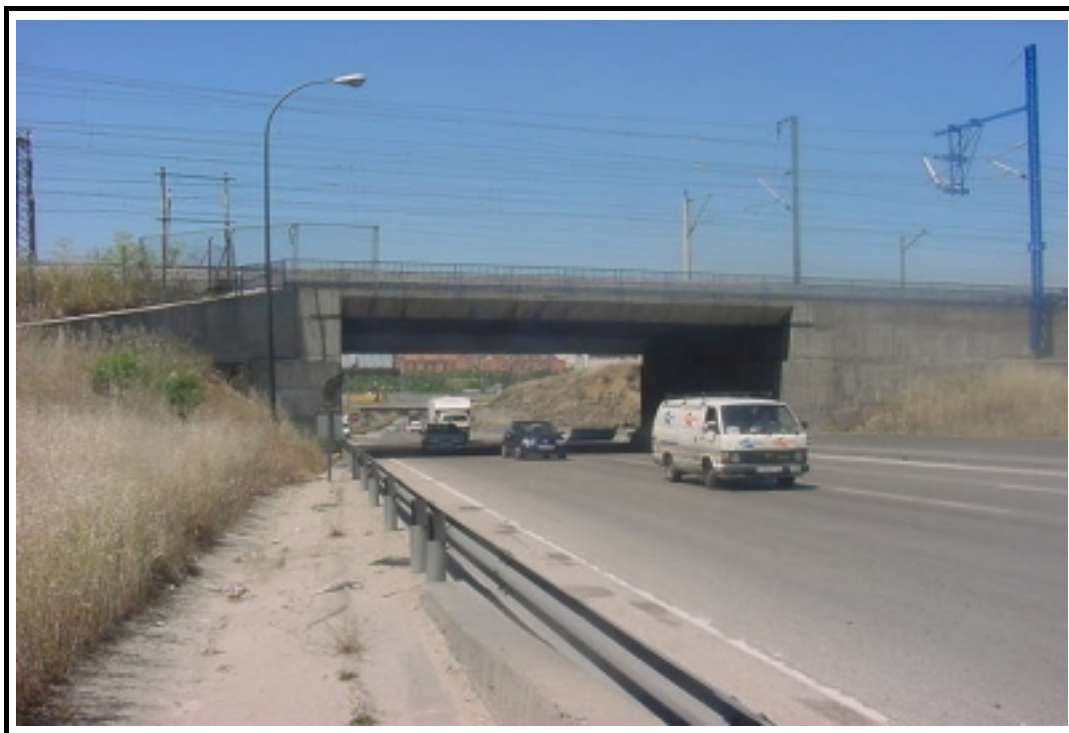
Foto 1: Vista general de la estructura E-2.1
