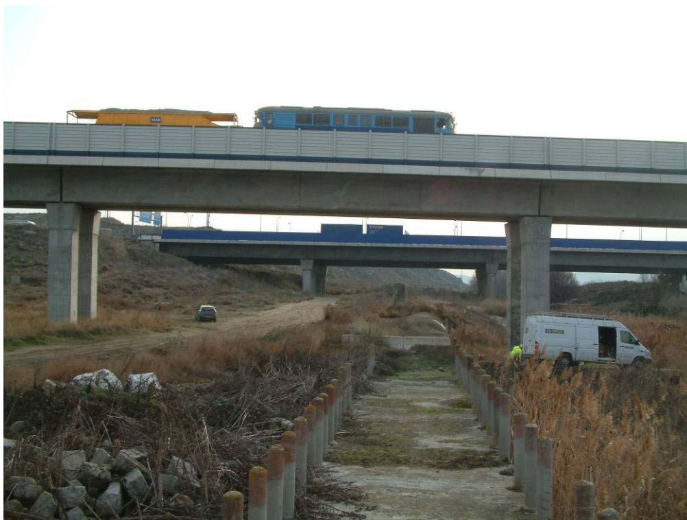
Nº 13.- Estado de carga en vano 2.
