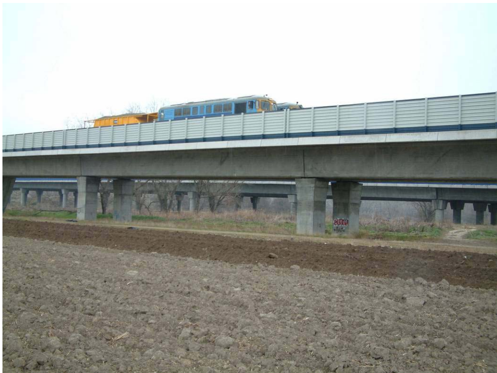
Nº 8.- Estado de carga en vano 13.
