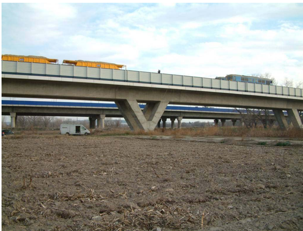
Nº 6.- Estado de carga en vanos 9 y 10.
