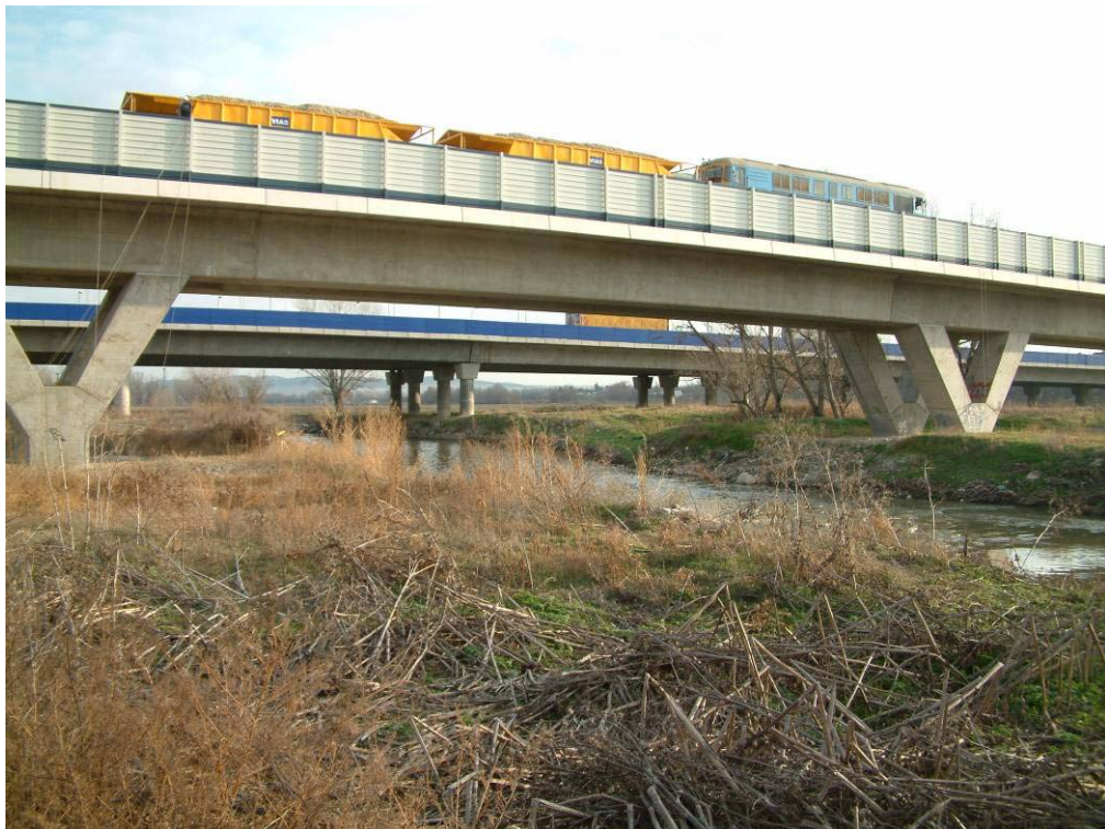
Nº 7.- Estado de carga Nº 10
