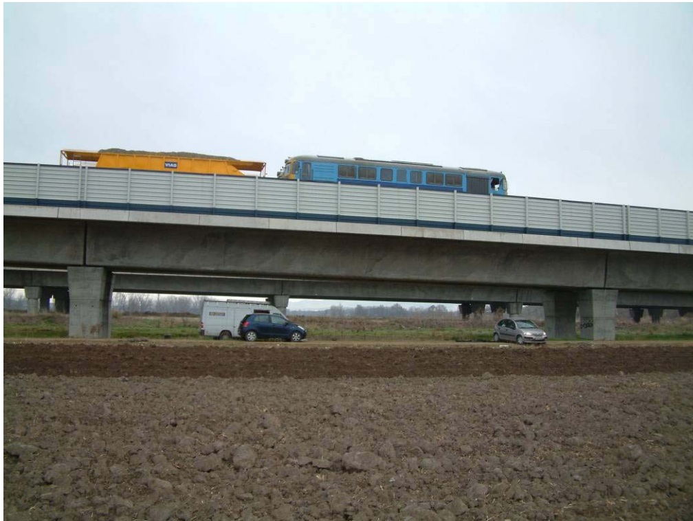
Nº 9.- Estado de carga en vano 14.
