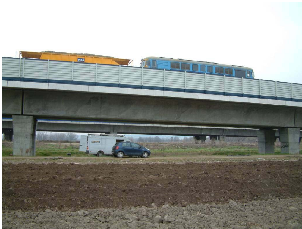
Nº 5.- Prueba de carga dinámica a 5 km/h con locomotora.
