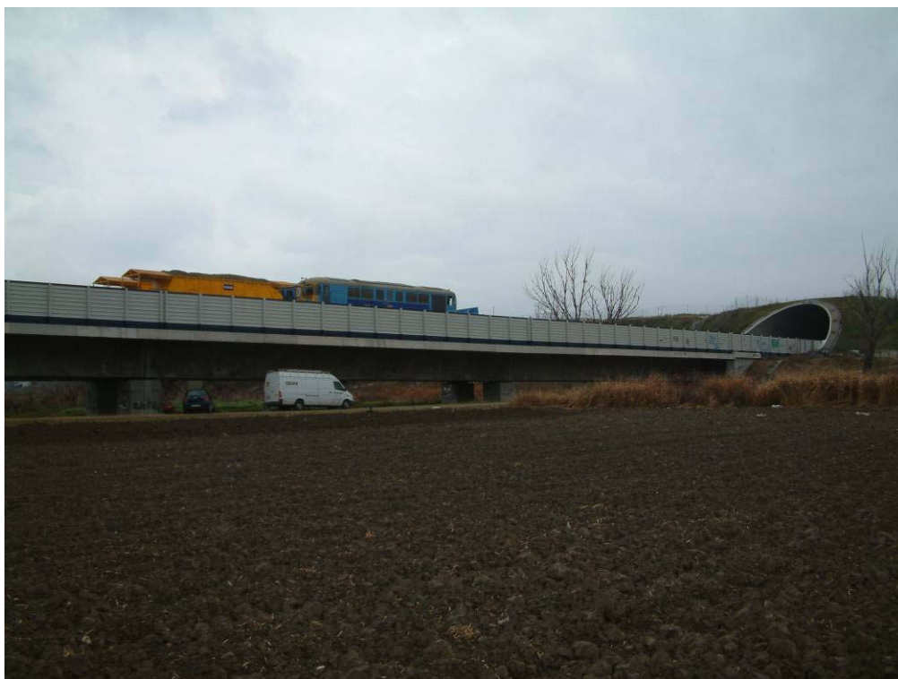
Nº 11.- Estado de carga en vano 17.
