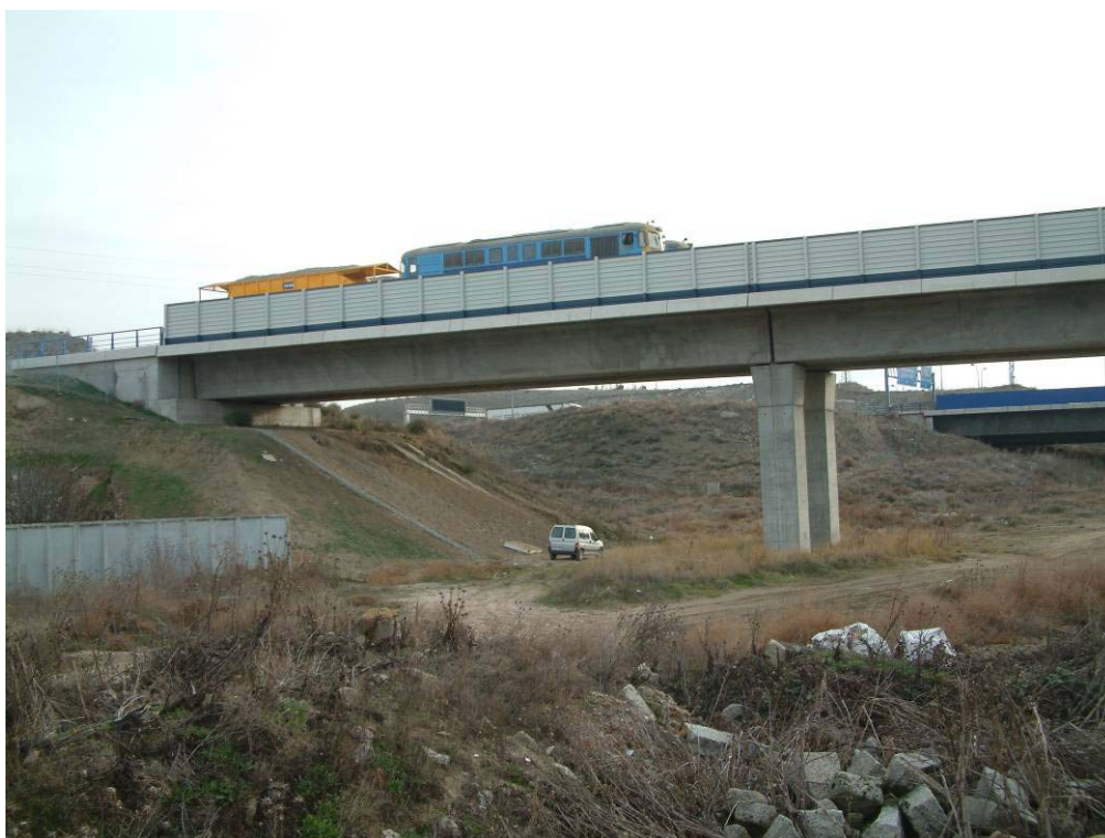
Nº 12.- Estado de carga en vano 1.
