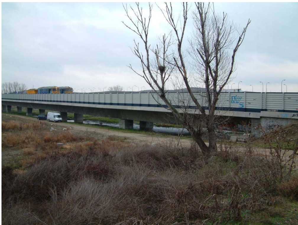
Nº 10.- Estado de carga en vano 16.
