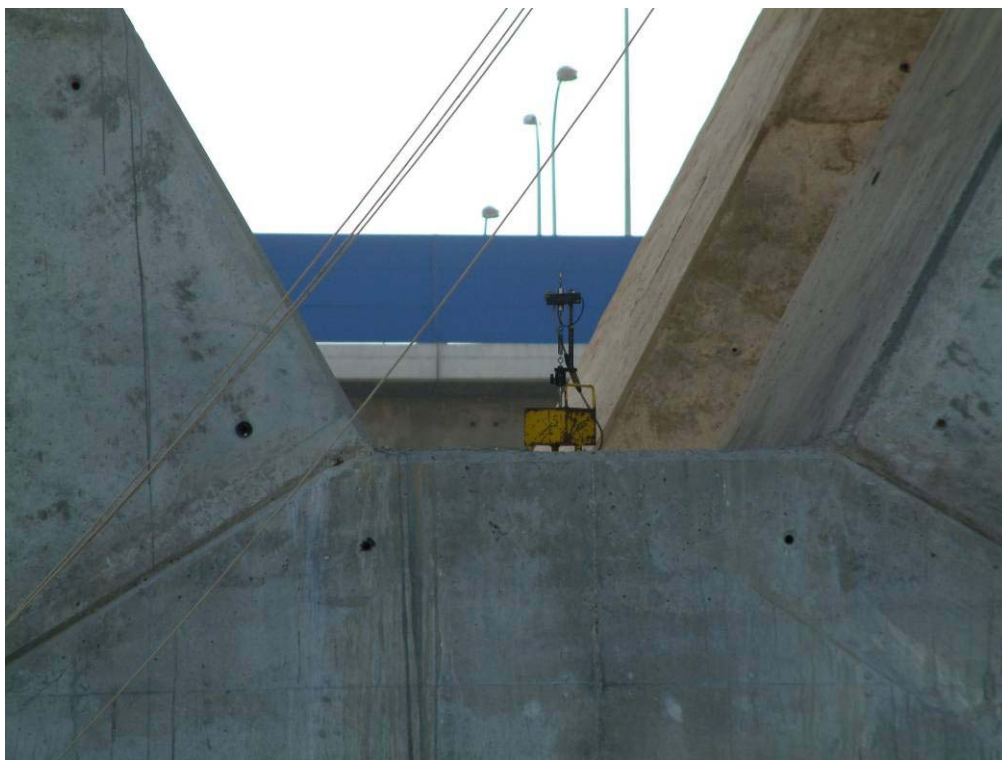
Nº 2.- Instrumentación con LVDT's en apoyos
