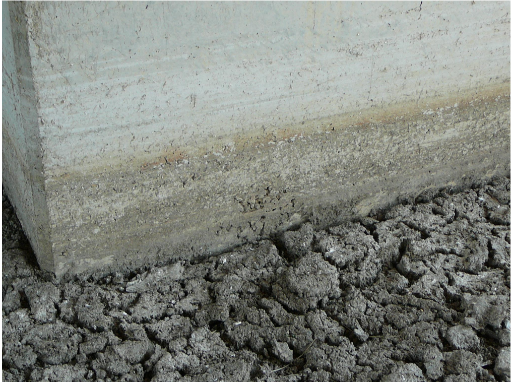
Nº9 Nido de grava en pila
