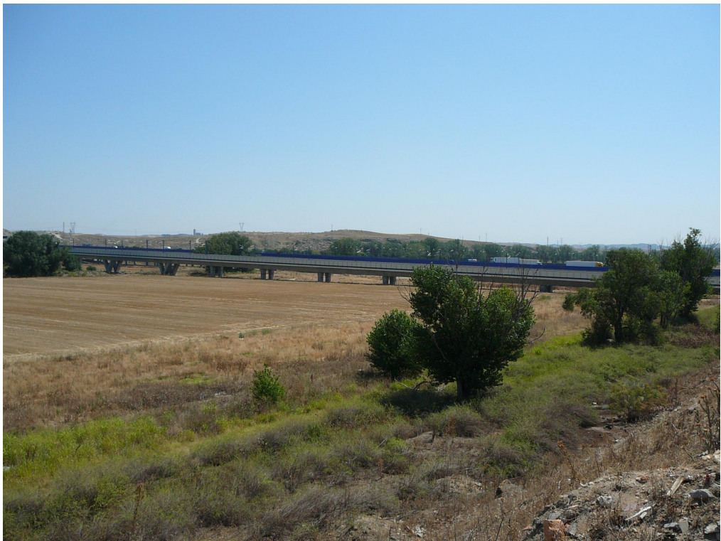
Nº10 Vista general de la estructura
